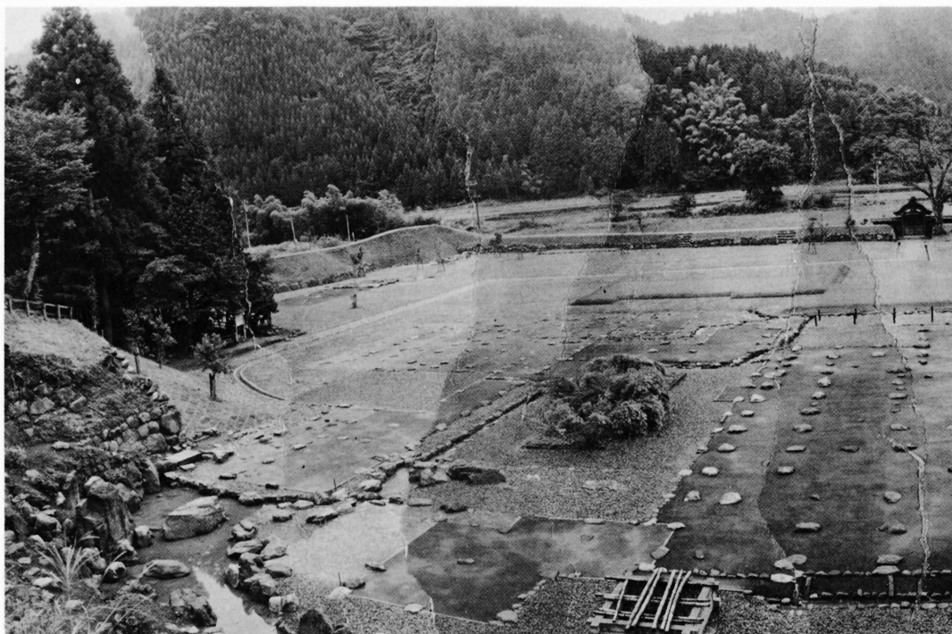
整備完成後の本館跡(東から)
