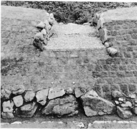
南門整備状況(北から)
