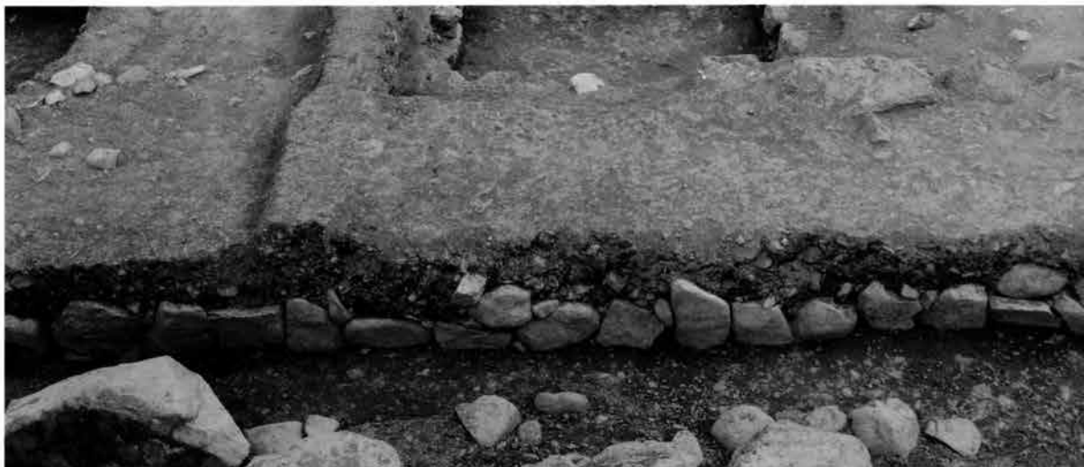
北面石垣 (東端部)
