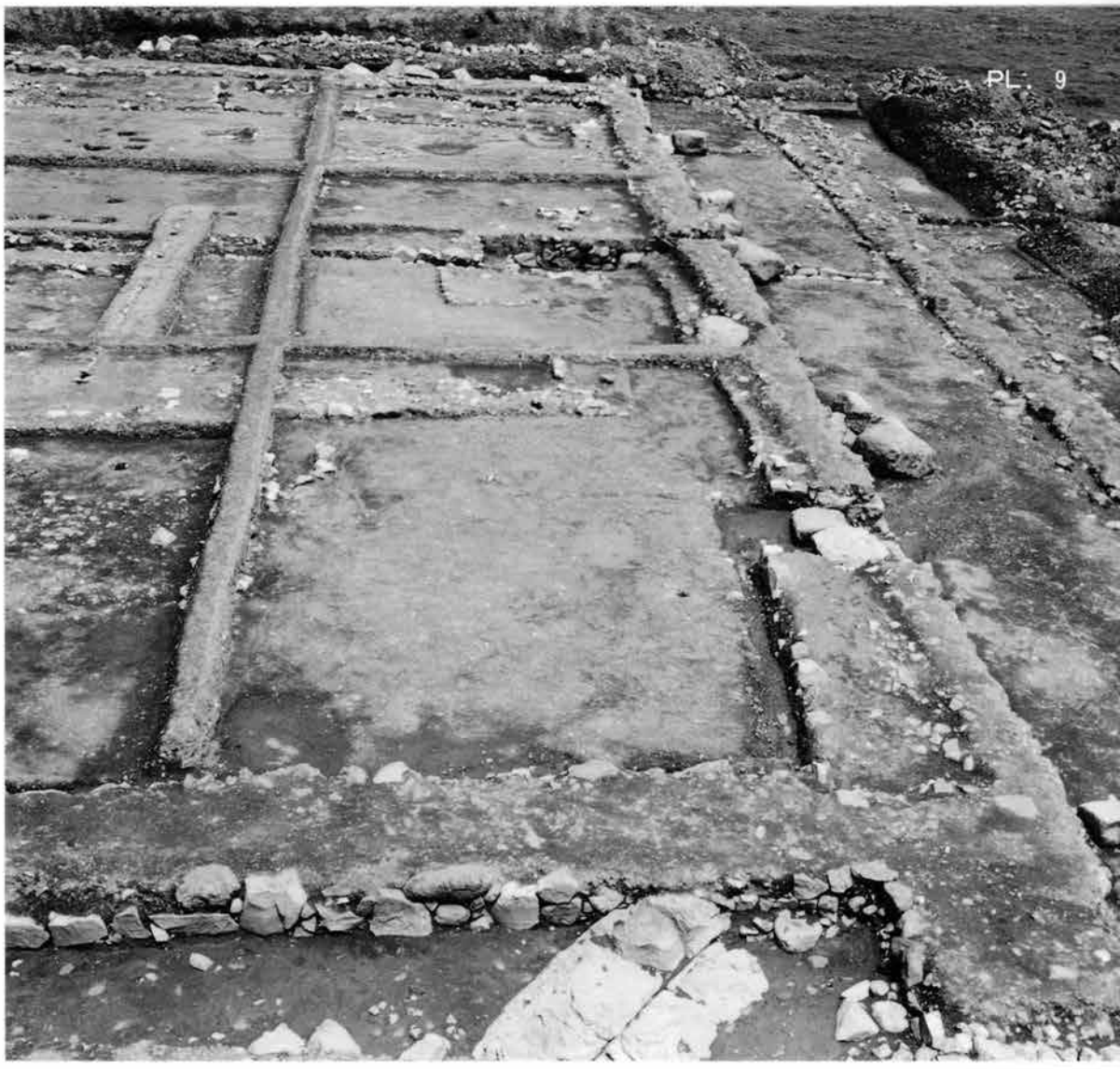
東端部 (南から)
