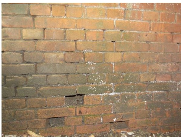
壁面レンガ積み 集水孔
