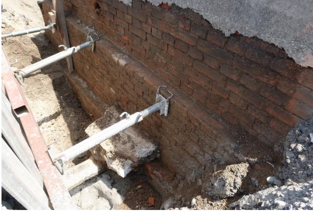
西壁レンガ積み、送水管
