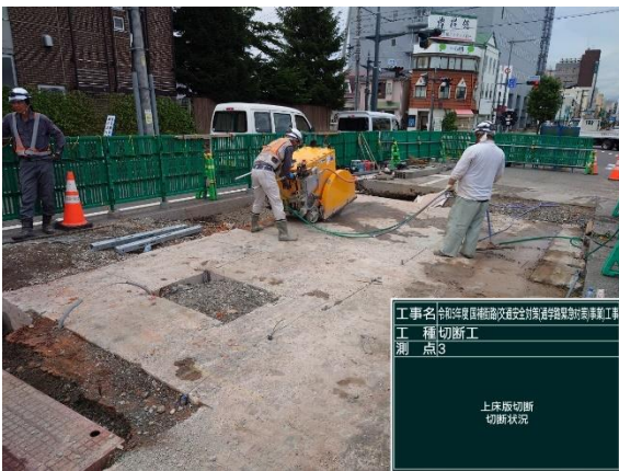
上部床版 切断状況
