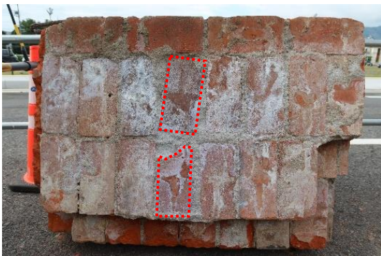
鉄道給水源跡 東壁面 平面方向切取
