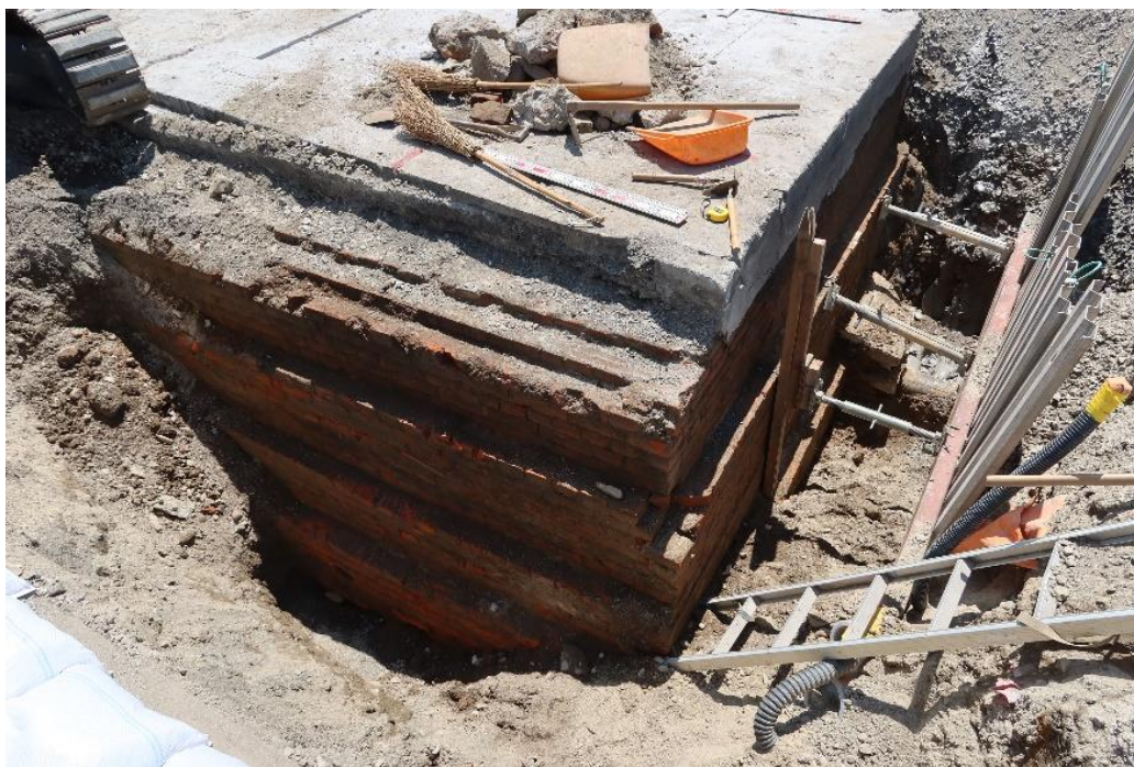
北西隠ぺい部壁面状況
