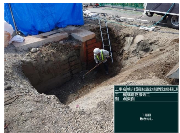
東壁面 埋め戻し
