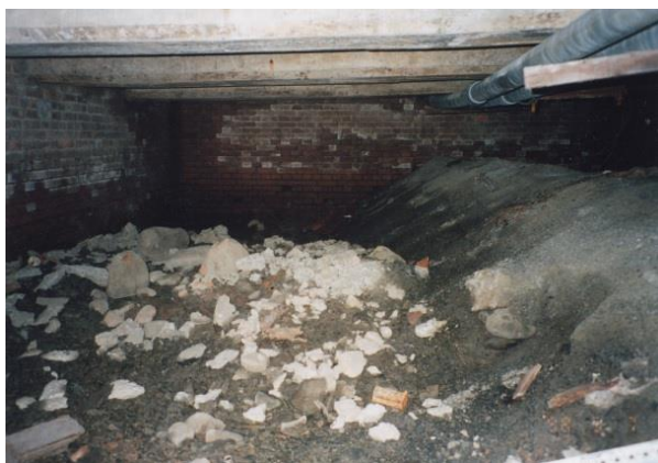
平成9年 内部の状況 1
