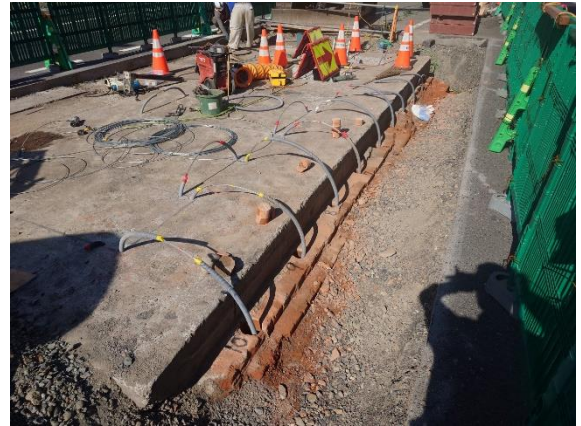
上部床版 全景
