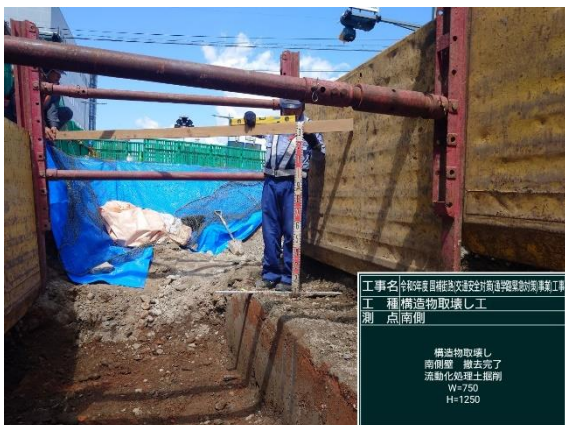
南側壁面 取り壊し完了
