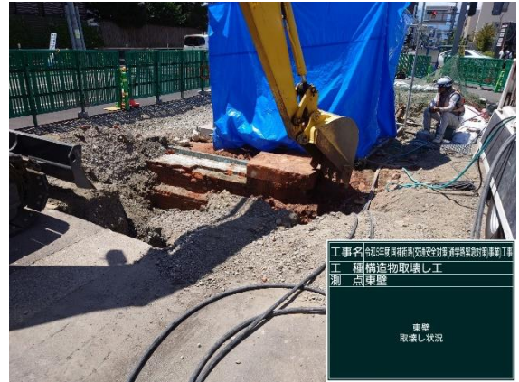
東壁面 取り壊し状況
