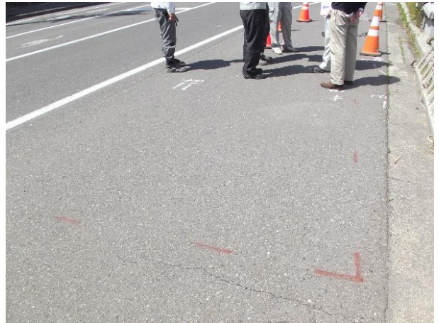
赤いラインが構造物埋設部分
