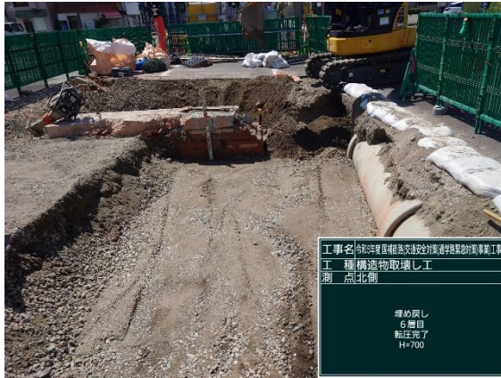
北壁面 埋め戻し
