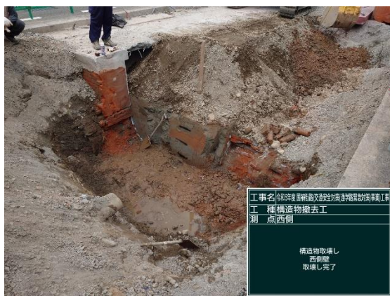
西壁面 取り壊し完了
