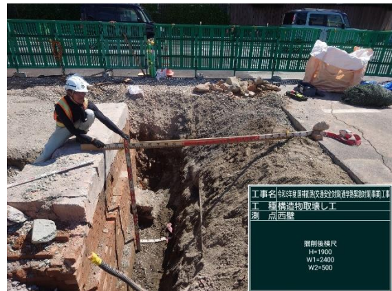
西壁面 掘削完了
