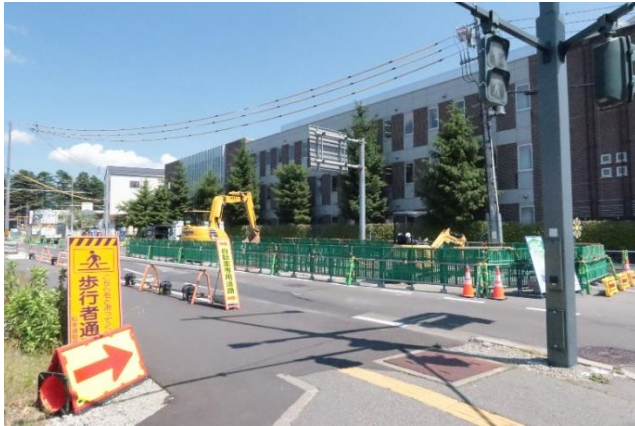
道路工事中 フェンス部分が貯水槽
