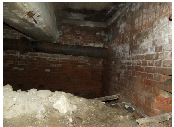
構造物を貫く配管
