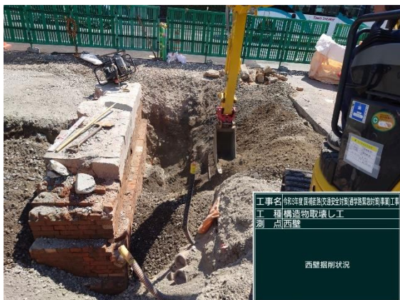
西壁面 側面掘削状況
