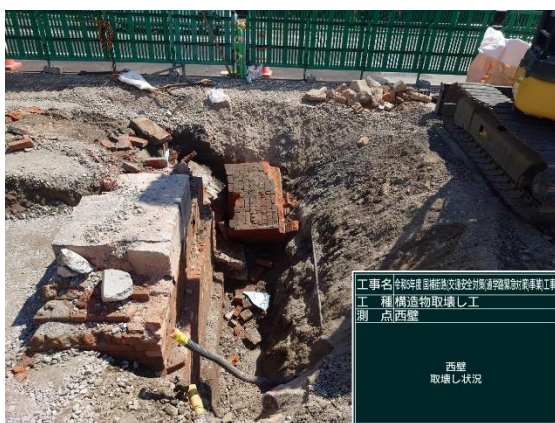
西壁面 取り壊し状況
