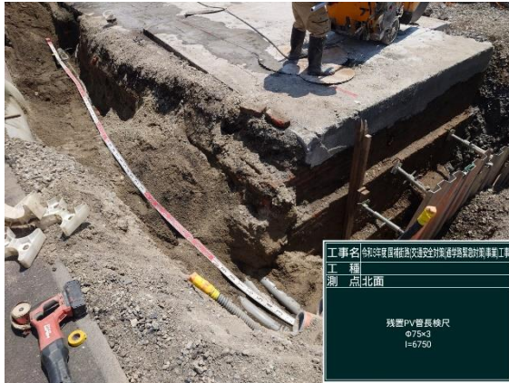
北壁面 掘削状況
