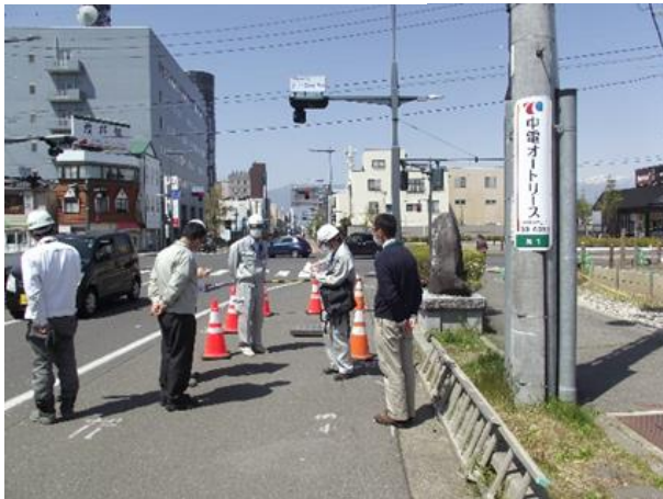
道路拡幅前 車道下部に給水
