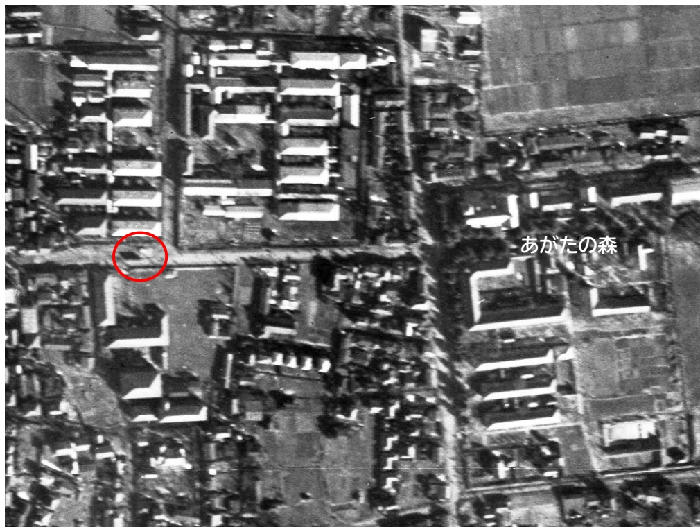
写真 1 昭和 23 年（1948）米軍航空写真 レンガ山周辺部分拡大 駅前通りに長方形の鉄道給水源跡、脇に浅間線電車が映る
