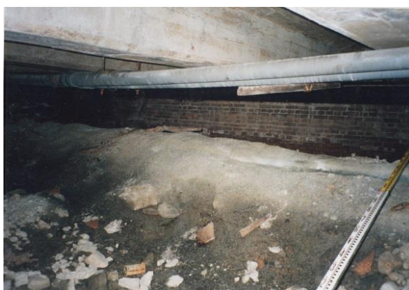
平成9年 内部の状況 2
