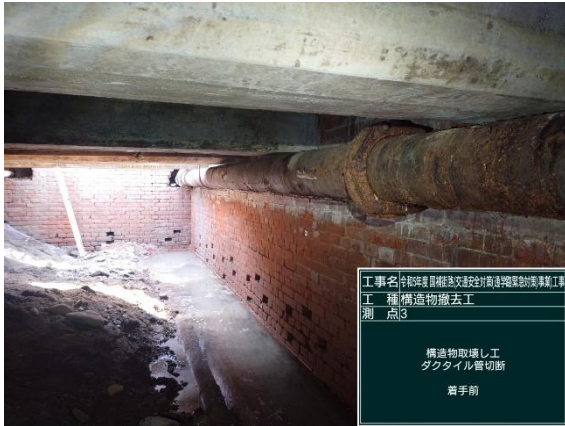
内部構造物 鋼管
