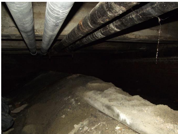
既存配管と堆積土
