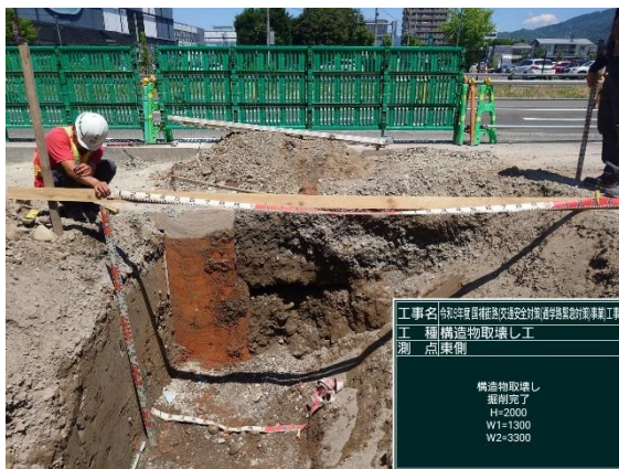
東壁面 取り壊し後
