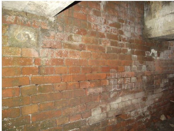
壁面レンガ積み状況
