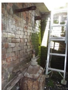
グレーチング下部
