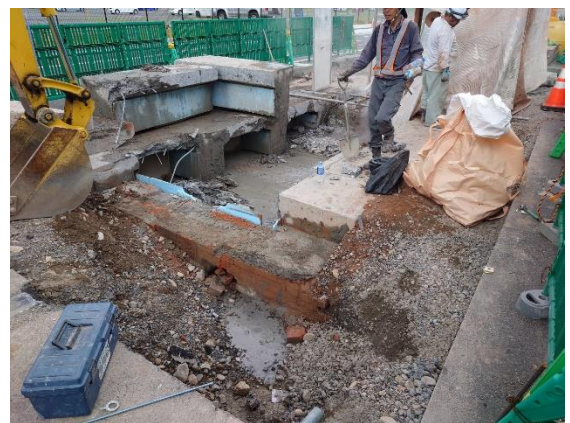
西壁面 取り壊し状況
