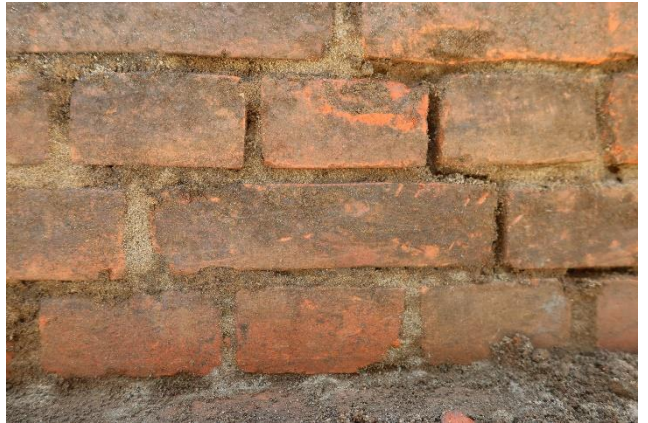
北壁レンガ目地 砂が多い
