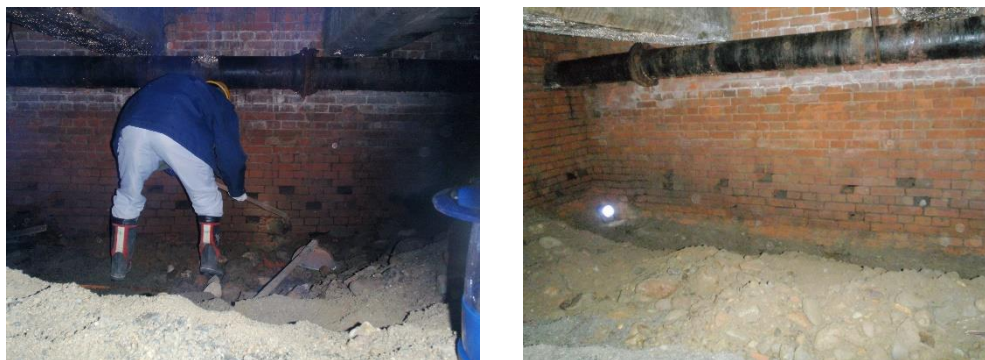
土の移設作業状況
