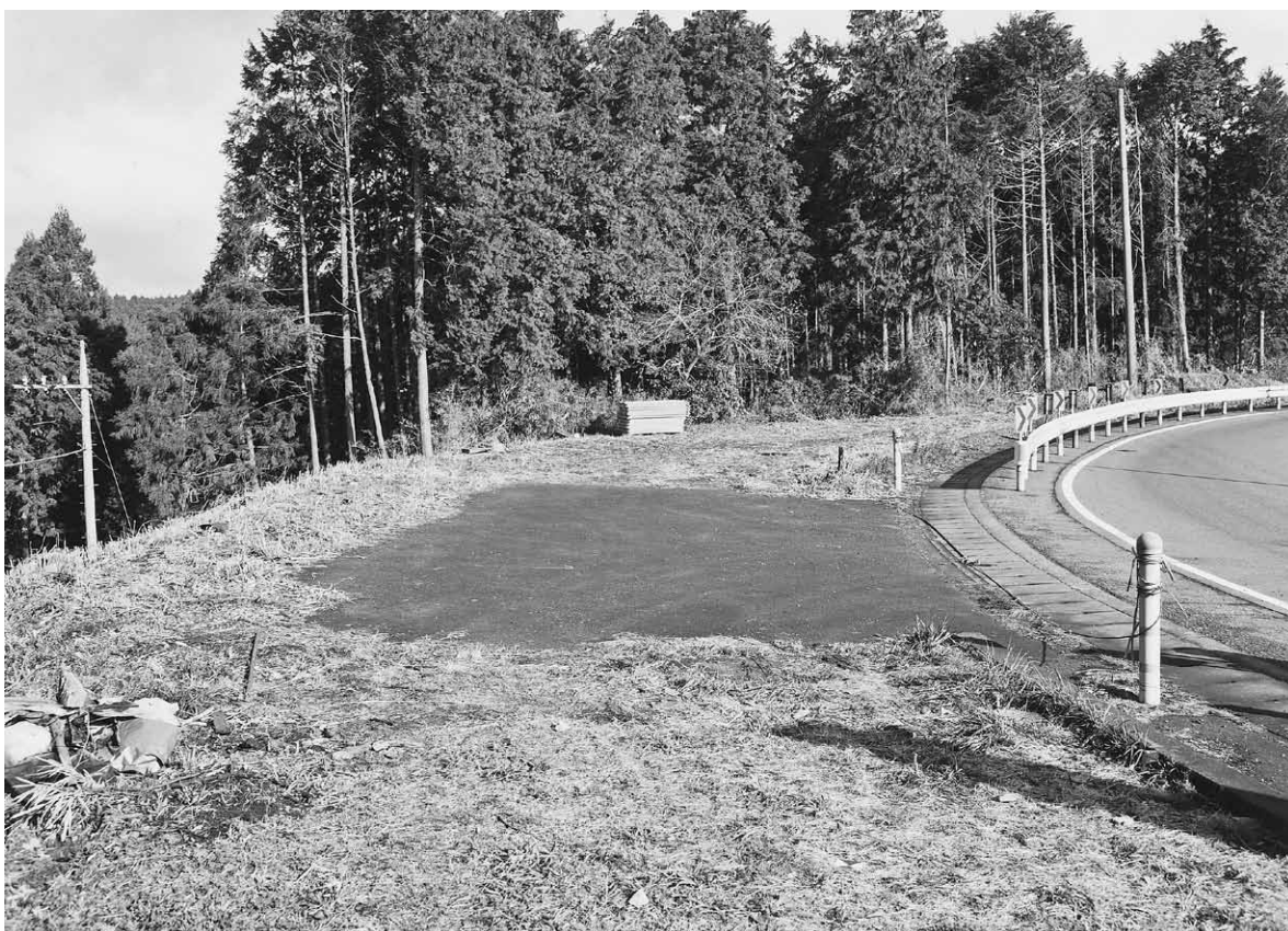
2. 調査前全景（南から）
