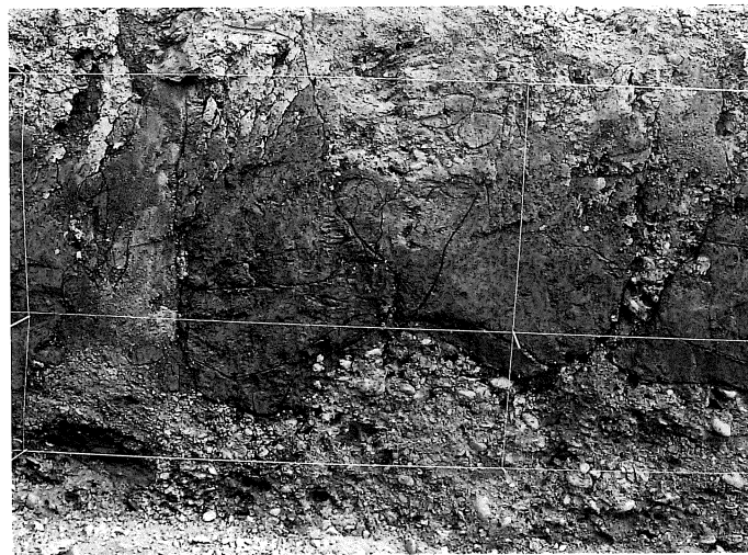
トレンチ内に見られた噴砂
