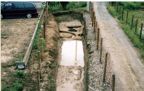
2 A区全景（南西から）
