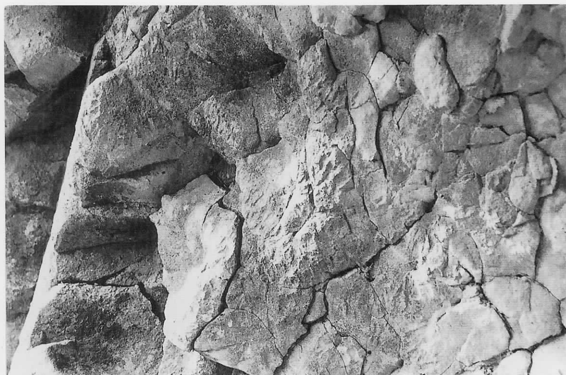
左側壁の工具痕
