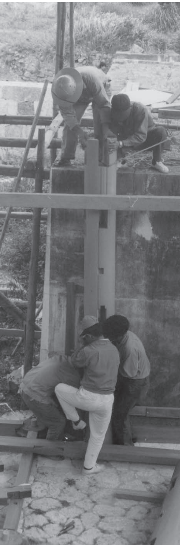
総門の復元工事の様子
