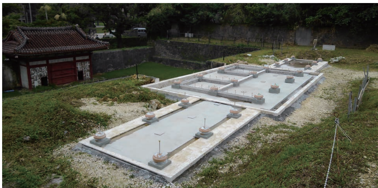
三門基壇コンクリート基礎工実施後（令和3年度）
