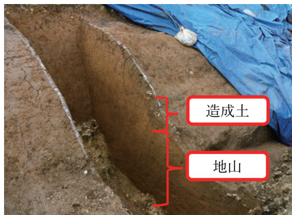
トレンチ1 サブトレンチ5
