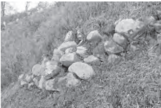
石垣e-1東半部
