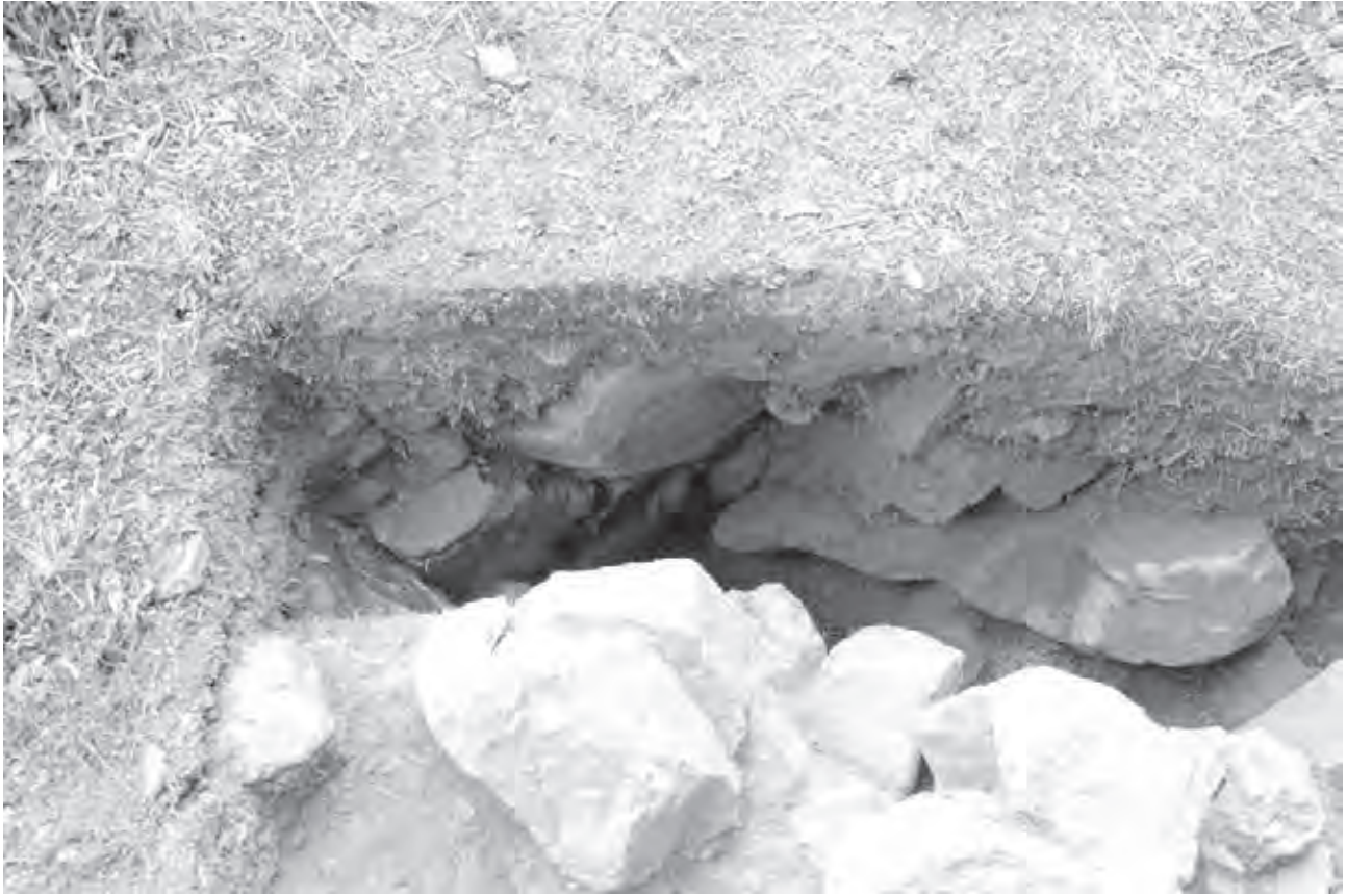
石垣 SW040101 上から
