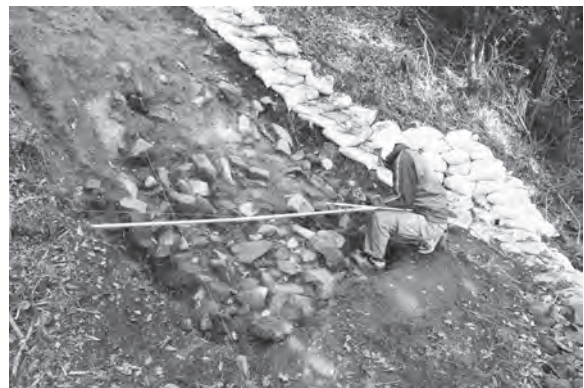
写真2 崩落石垣実測作業 平成24年12月19日撮影
