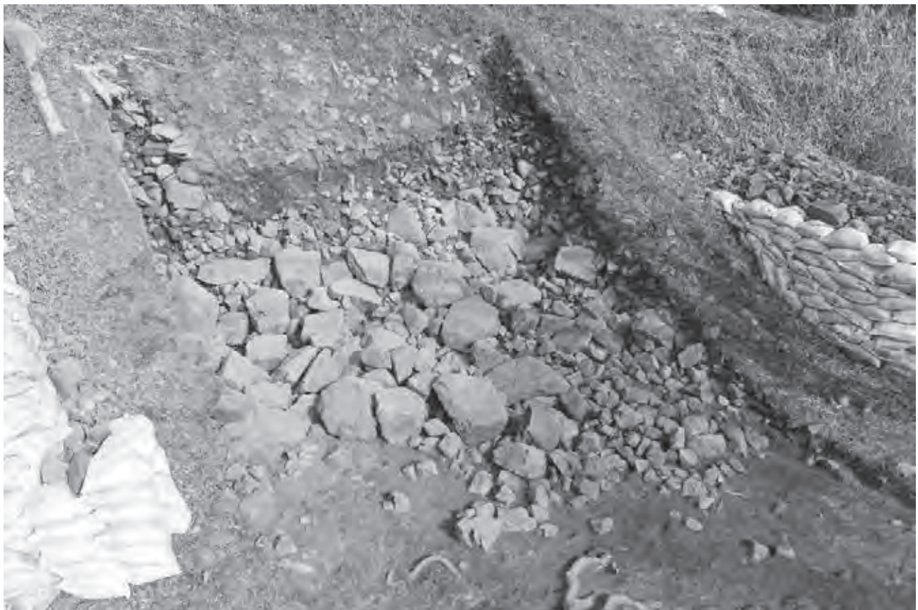
石垣 SW020101 崩落状況下層 西から
