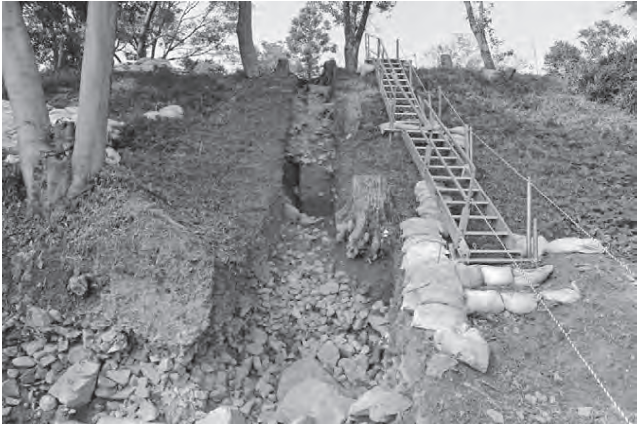
C-3トレンチ全景 下から
