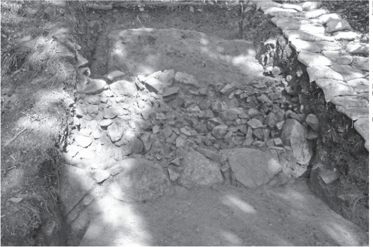
石垣 SW012201 南東から
