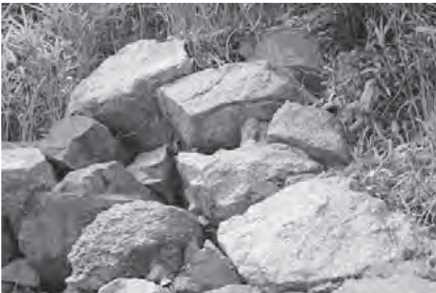
石垣e-2西半部 矢穴痕のある築石①
