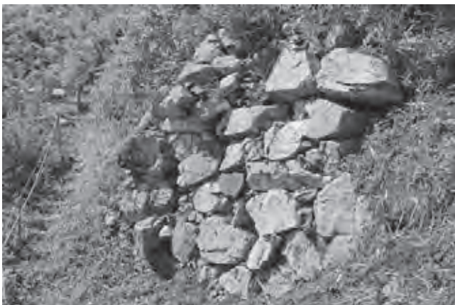
石垣e-2東半部
