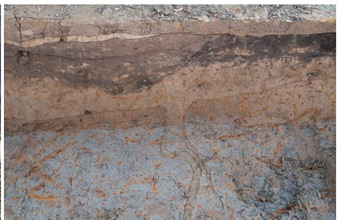
2区 SX3 噴砂痕(北から)
