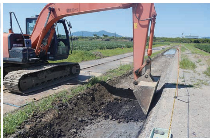
1 区 表土掘削 (東から)
