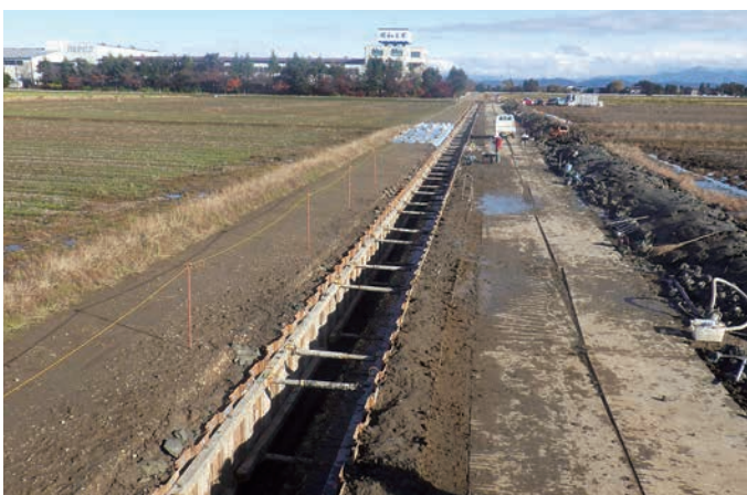
1区下層 完掘(西から)
