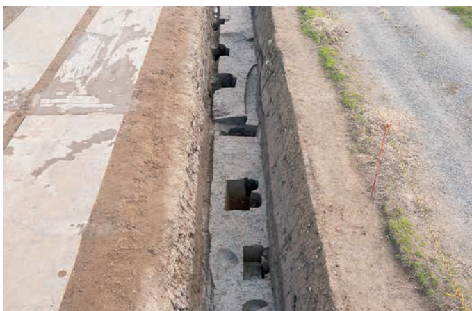
3区 SB71 (P24・46・65・62・32・47) 柱根検出状況 (西から)
