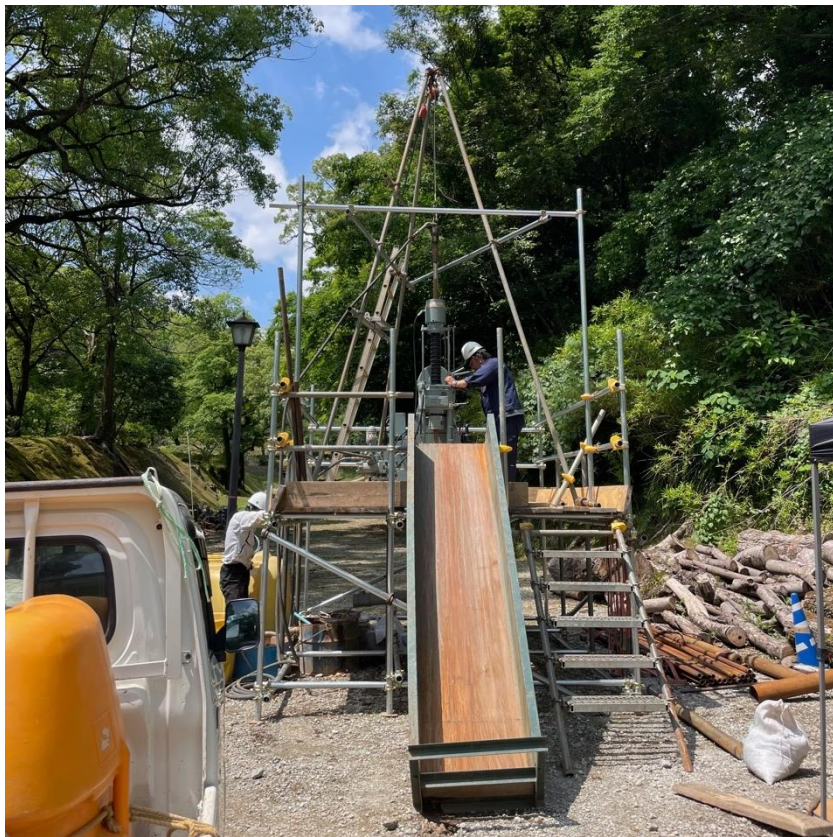
図 6. 熊本城公園における地質調査（ボーリング調査）の様子（2024年6月）
