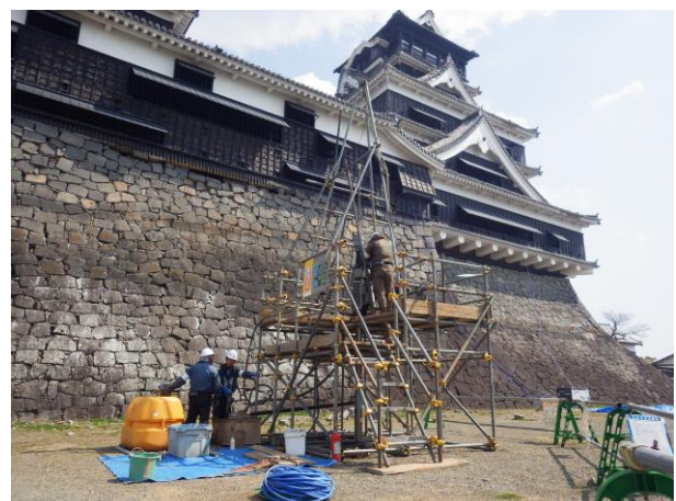
写真1 天守閣前ボーリング調査状況（北西から）
