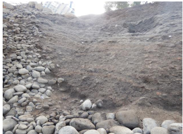
写真7 平櫓石垣背面の盛土、栗石の状況
