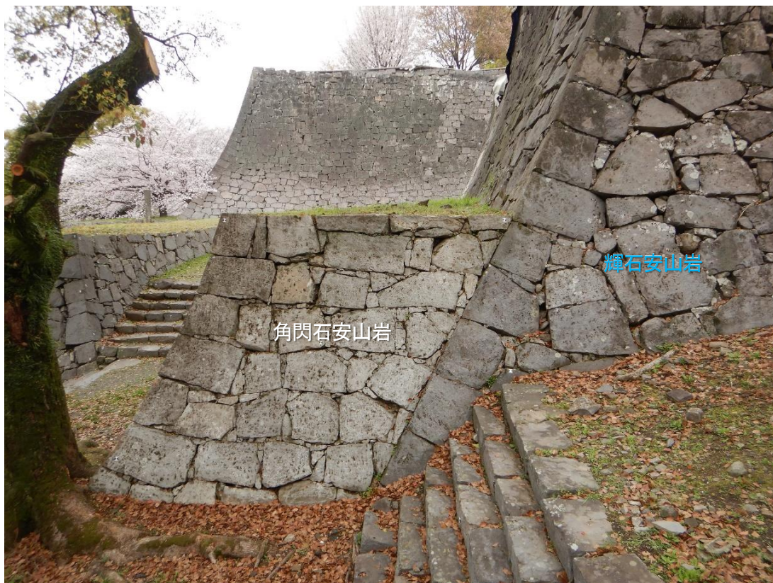
写真10 竹の丸五階櫓石垣東面
