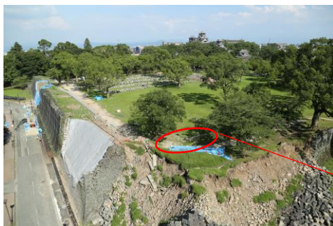
写真4 百間石垣確認調査地点遠景(西から)
