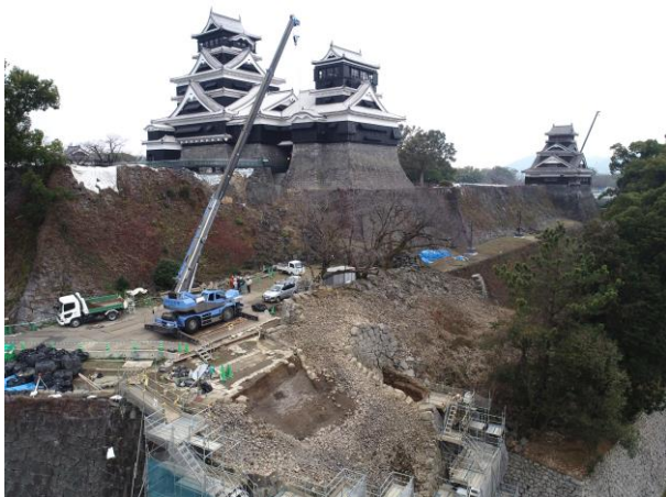
写真6 石垣解体後の平櫓石垣
