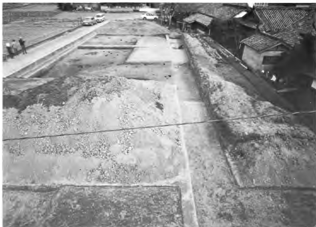
1. 金堂(?) 塔基壇検出状況 (西より)
