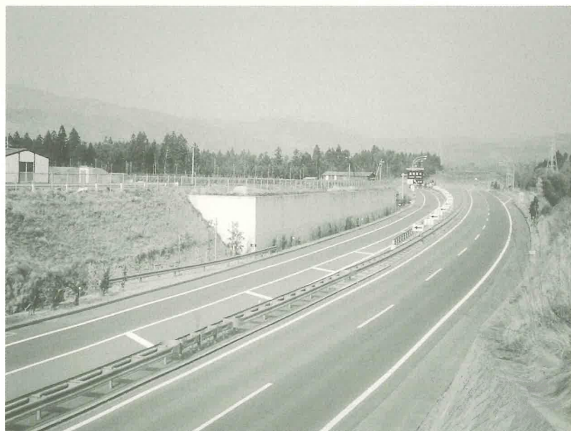
平成元年 1・2号方形環溝の保存擁壁
