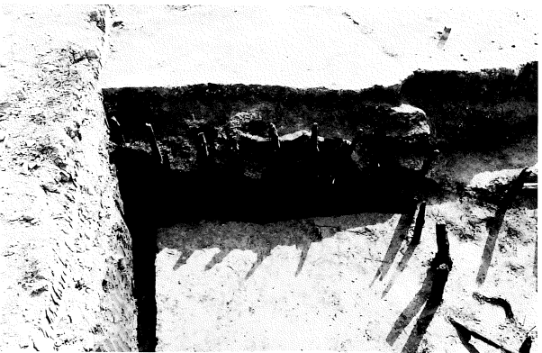
坝樋跡杭列状態（3）
