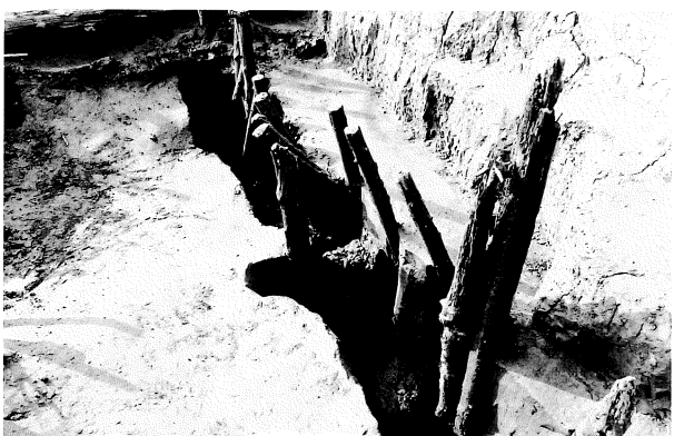
坝樋跡杭列状態（4）
