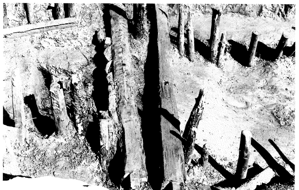
坝樋跡木組み状態
