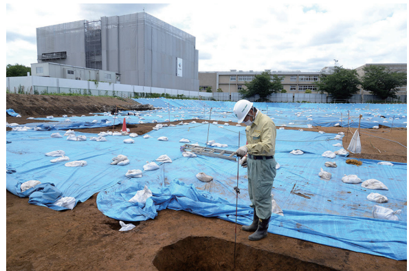
写真 150 測量作業風景（北西から）
