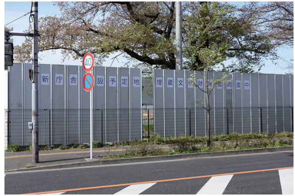
写真 140 仮囲いフェンス看板設置状況（南から）
