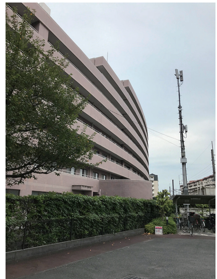
第98図 建物外壁が歪曲したマンシオン
