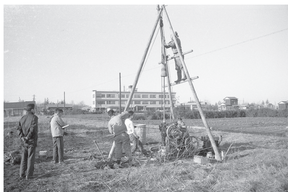
第87図 町役場新築に伴う地盤調査 (昭和36年)
