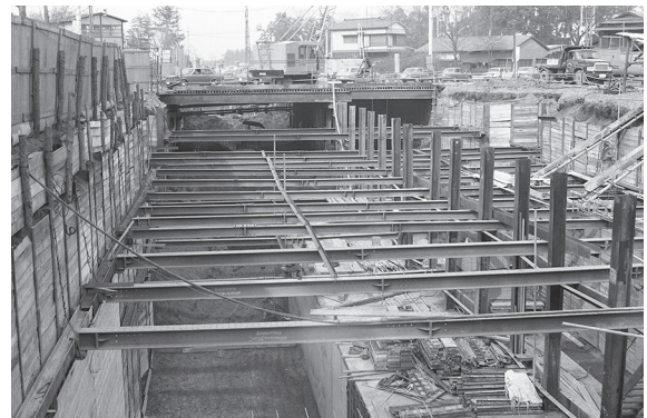
第 102 図 工事中の武蔵野線 (昭和 45 年)
