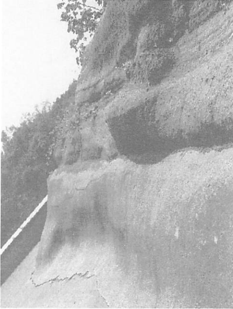
写真1. 保存施設屋根と円山の接合部
