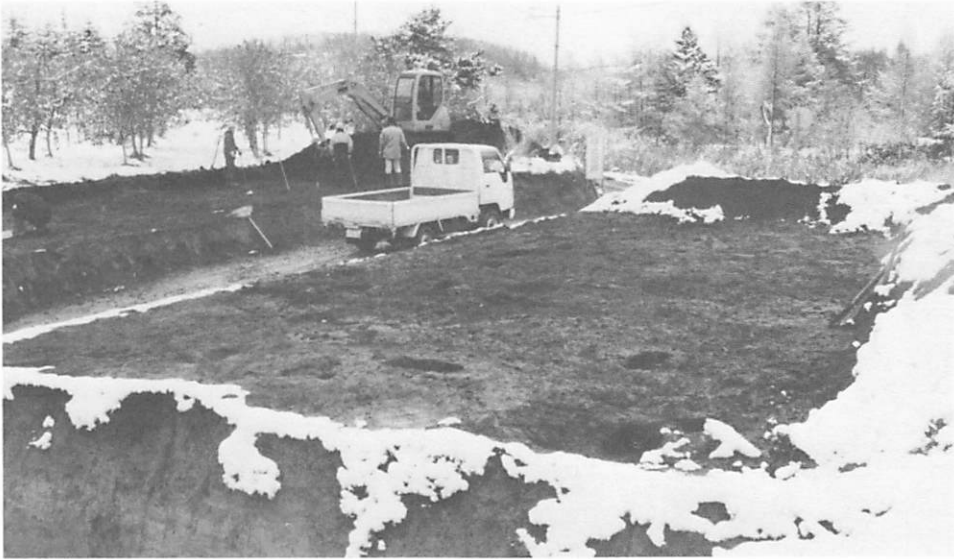
2、第2回工事立会
