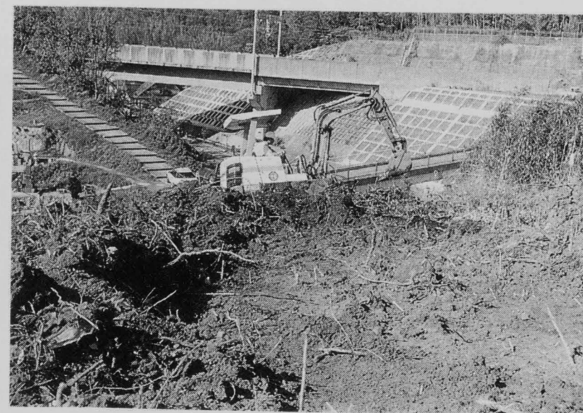
重機による表土除去
