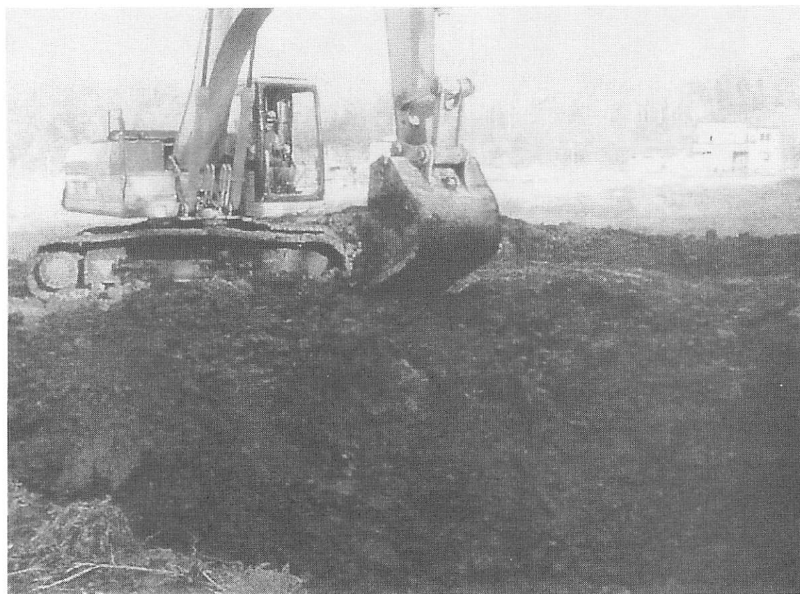
埋め戻し状況
