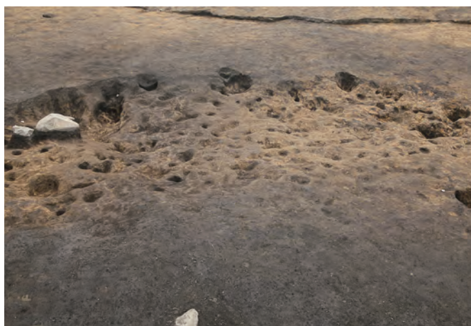
3 1号溝硬化面(東から)
