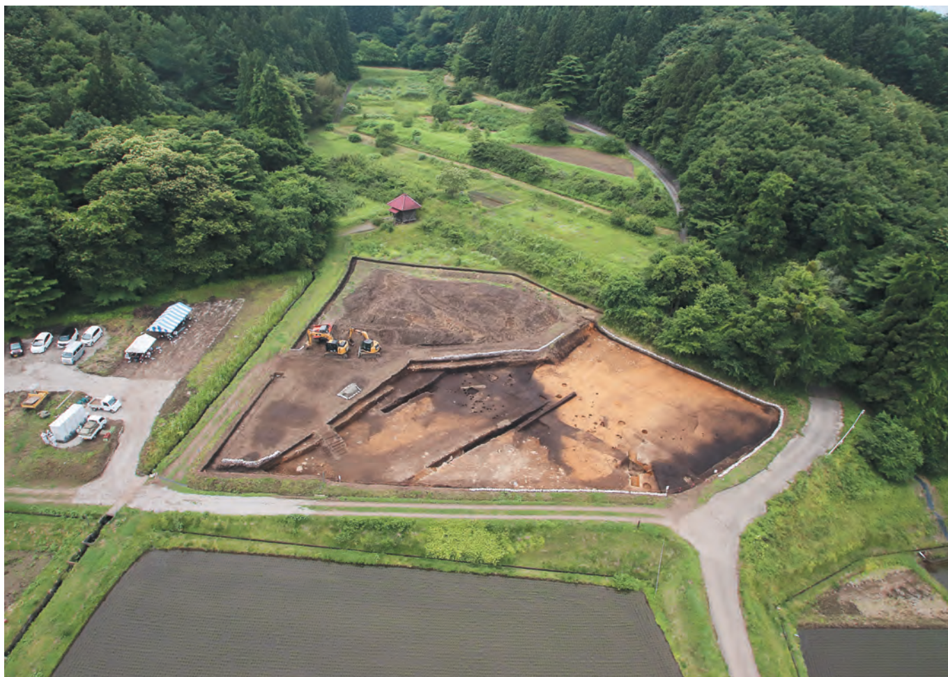
調査区空中写真(北東から)
