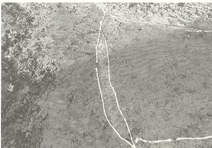
道路B 溝①②間
