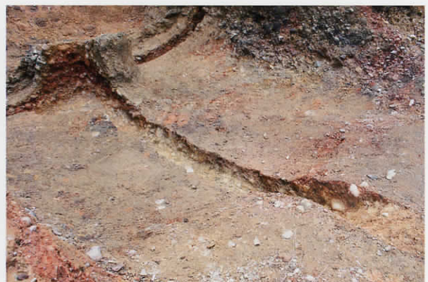
主軸断ち割り状況7-9m付近(北より)
