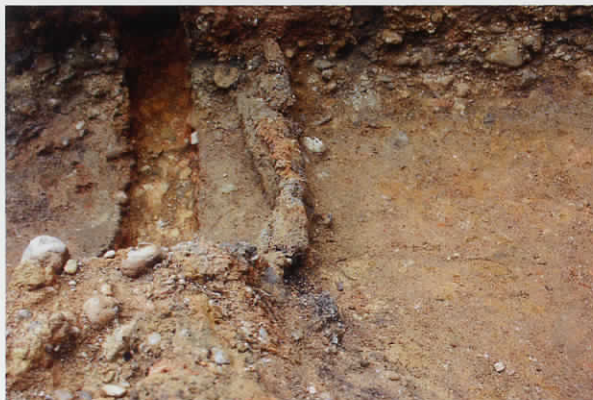
間仕切り障壁左側(南より)
