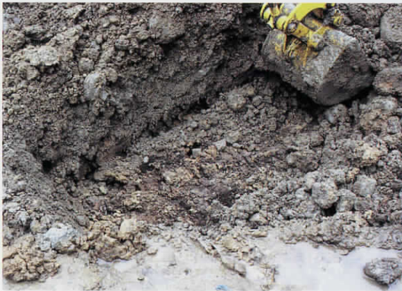
基礎掘削部分（東より）
