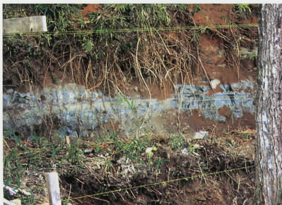
岩盤露出部分（東より）
