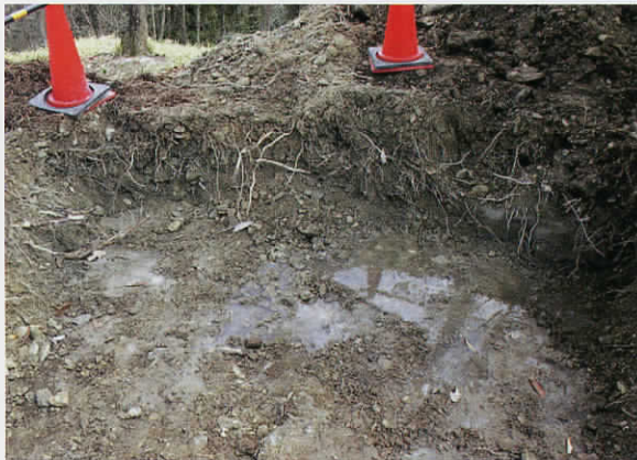
掘削状況断面（南より）
