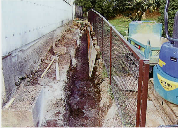
掘削溝全景（西より）
