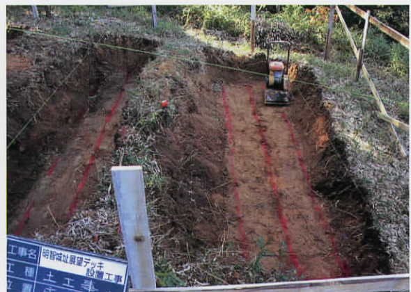
基礎掘削部分平面（南より）
