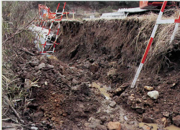
護岸工事部分全景（南より）
