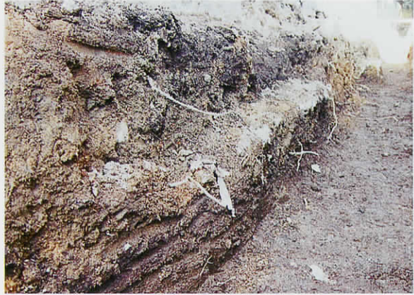
既設建物の基礎下、旧包含層（西より）
