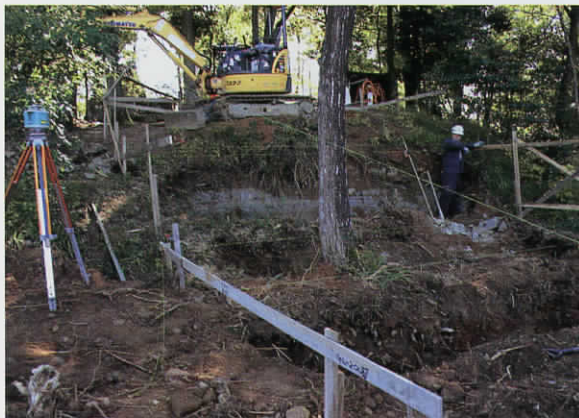
展望デッキ設置部分（南より）
