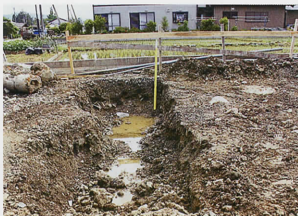
基礎工事部分（西より）
