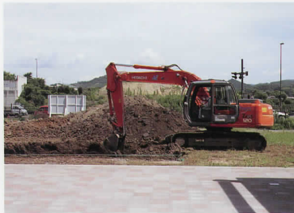
重機作業風景
