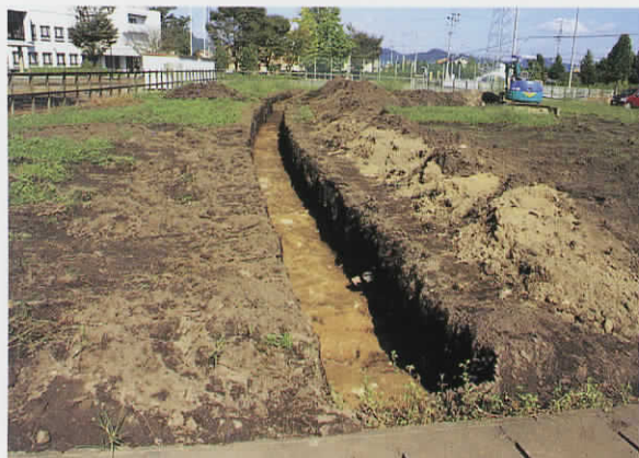
東西トレンチ西部分 (西より)
