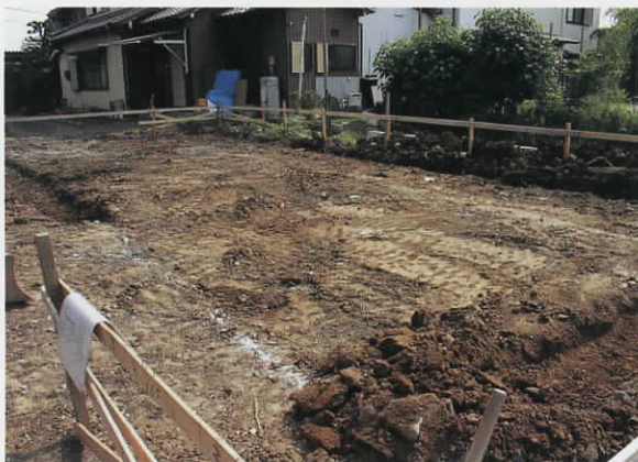
住宅部分基礎工事風景（北より）
