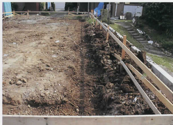
住宅部分基礎工事西側部分（北より）
