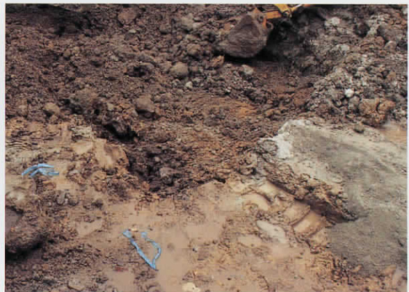
基礎掘削部分（東より）
