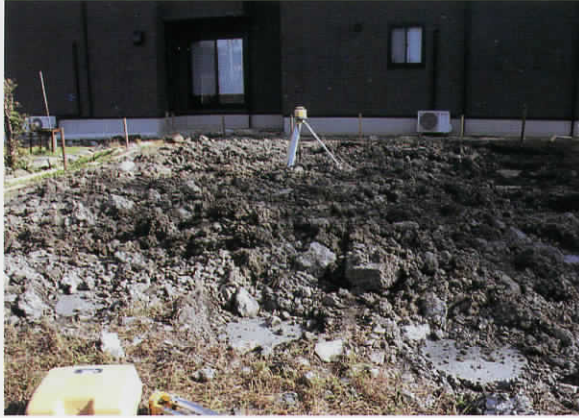
掘削後（西より）
