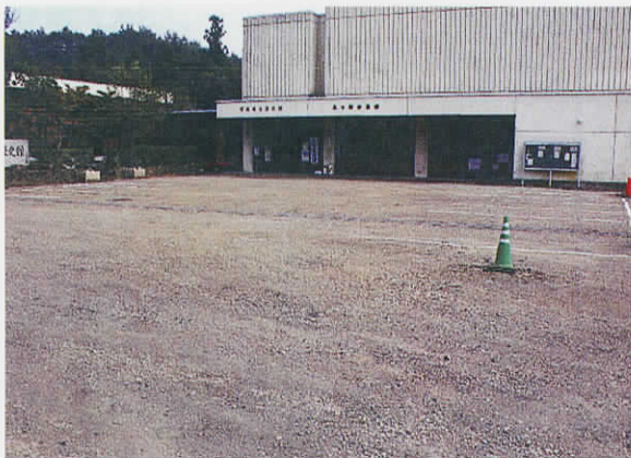
既設舗装除去後 (北より)
