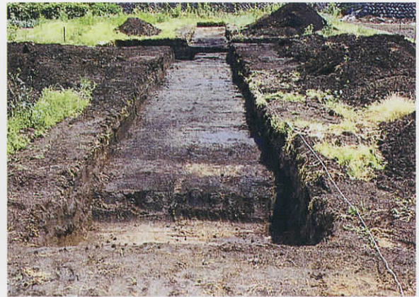
トレンチ完掘全景 (北より)
