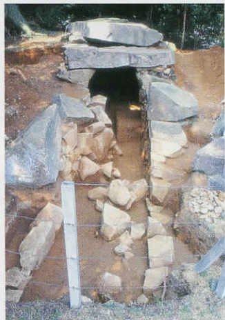
羨道閉塞石及び西側壁崩壊部
