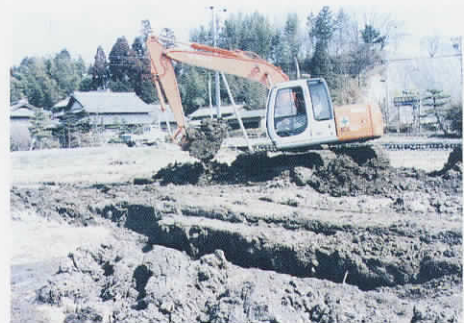
山岸・伊川地内重機による埋め戻し
