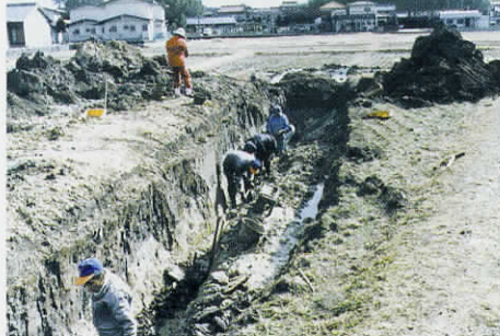
山岸・伊川地内作業風景
