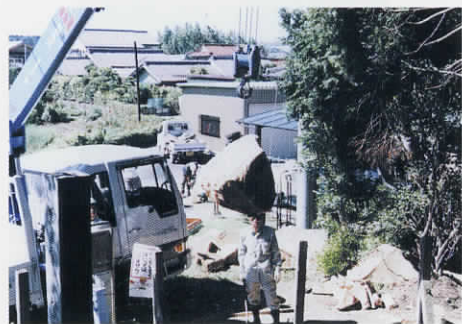
石積み直し作業
