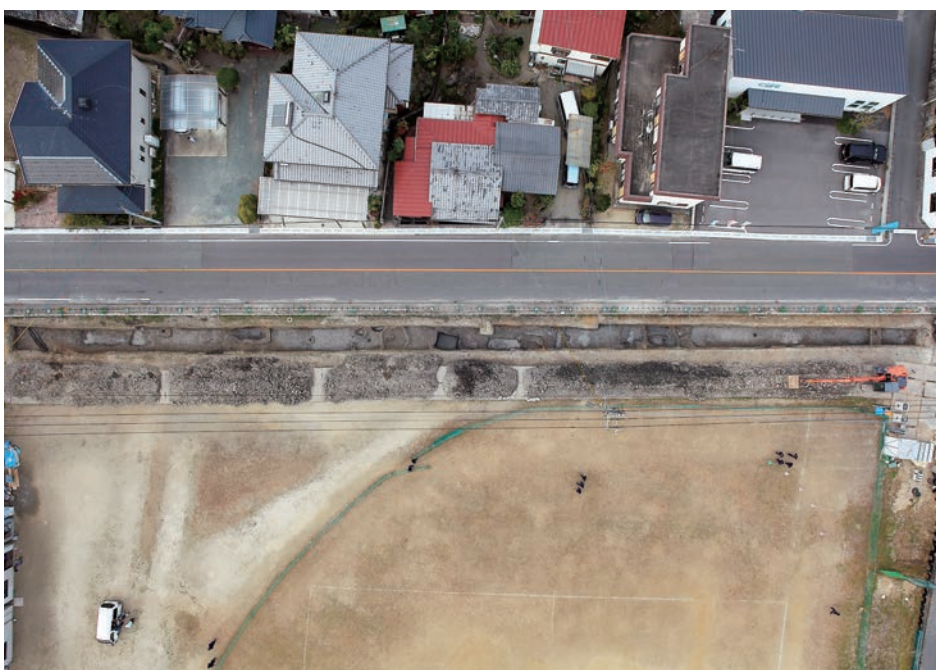
3 第2遺構面全景 (直上)
