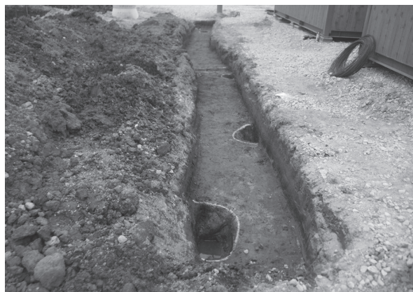
SP136・139 完掘 (北西から)
