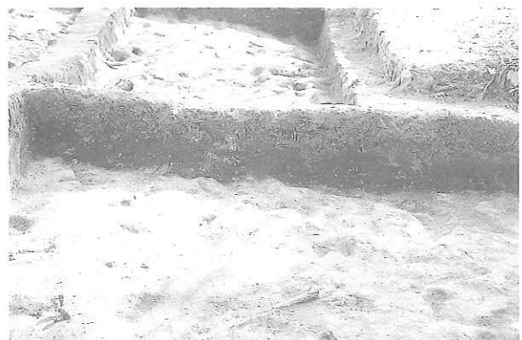
道路面上堆積状況
