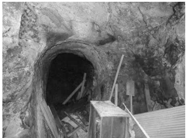
写真6 図面S付近
