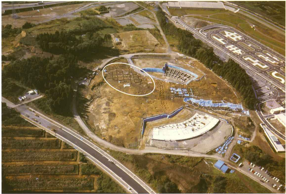
旧野球場建設予定地（白枠内が南盛土）
