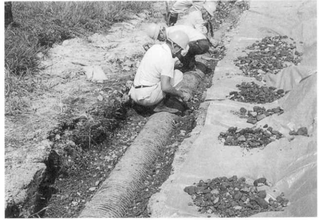
2 排水溝掘り出し作業
