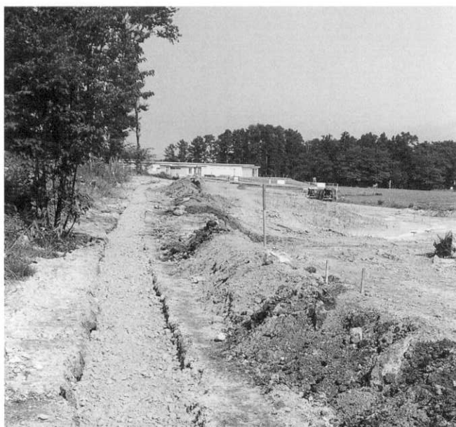
写真1 暗渠排水施設(南東から)
