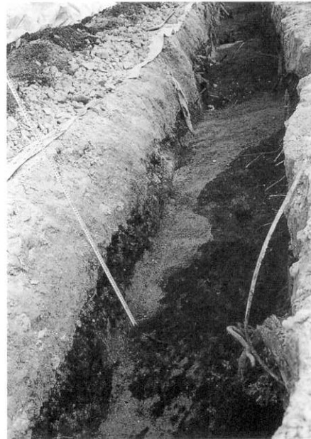
4 南側の第III層損傷部分 (No.10付近)
