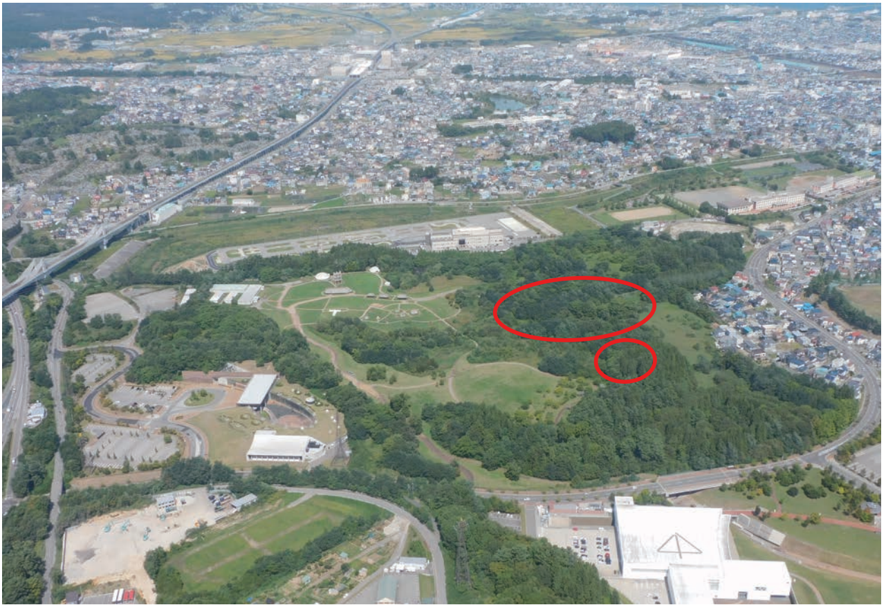
遺跡全体（上：旧都市計画道路予定地付近 下：南地区東側） S →
