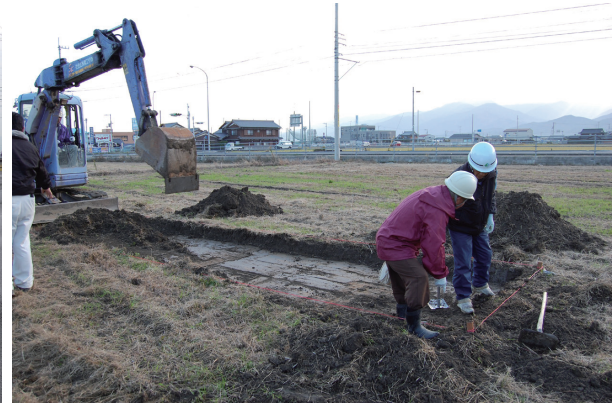
写真 1 - 2 重機による表土剥ぎ取り状況
