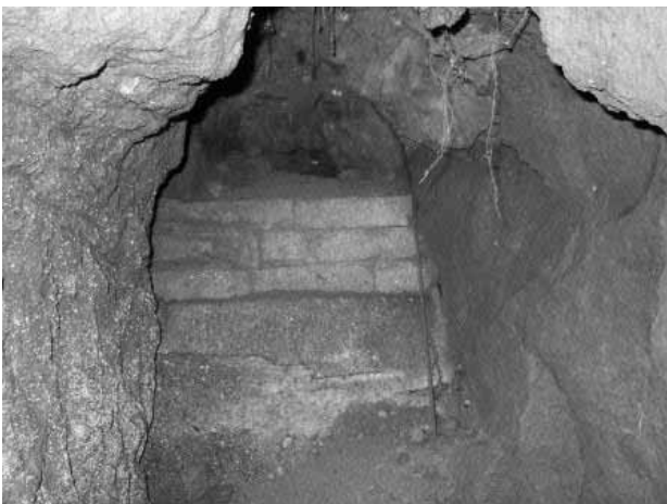
写真5 図2-⑤ 埋め戻された通路 2019.6.18 撮影
