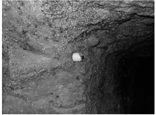
写真2 図2-②付近 残された照明器具 2019.6.18 撮影
