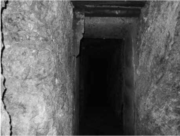
写真3 図2-③付近 コンクリート構造通路 2019.6.18 撮影
