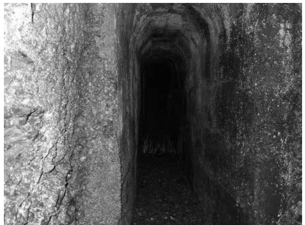
写真6 図2-⑥付近 コンクリート構造の通路 2019.6.18 撮影
