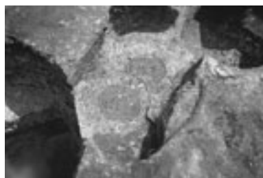
9760 (中)・9761 (上)・9762 (下) ピット 柱痕確認
