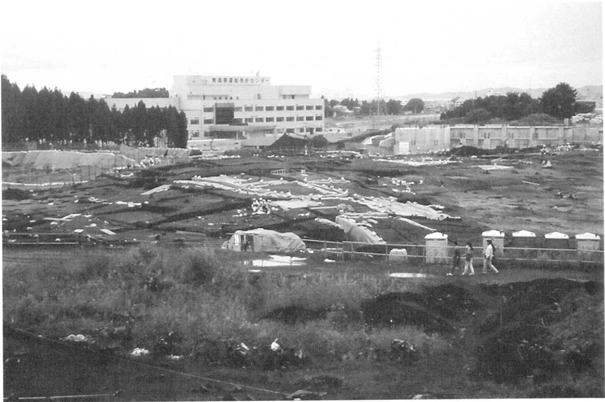
南盛土近景（南から）
