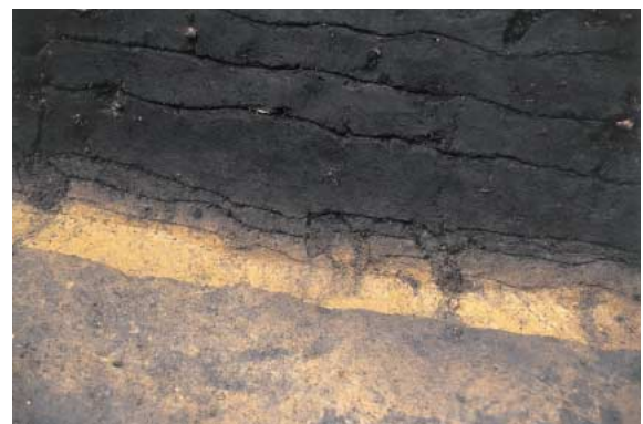
貼り土の断面（東から）
