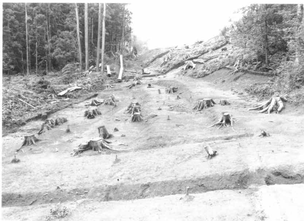
C調査区 近世平坦面全景（東より）
