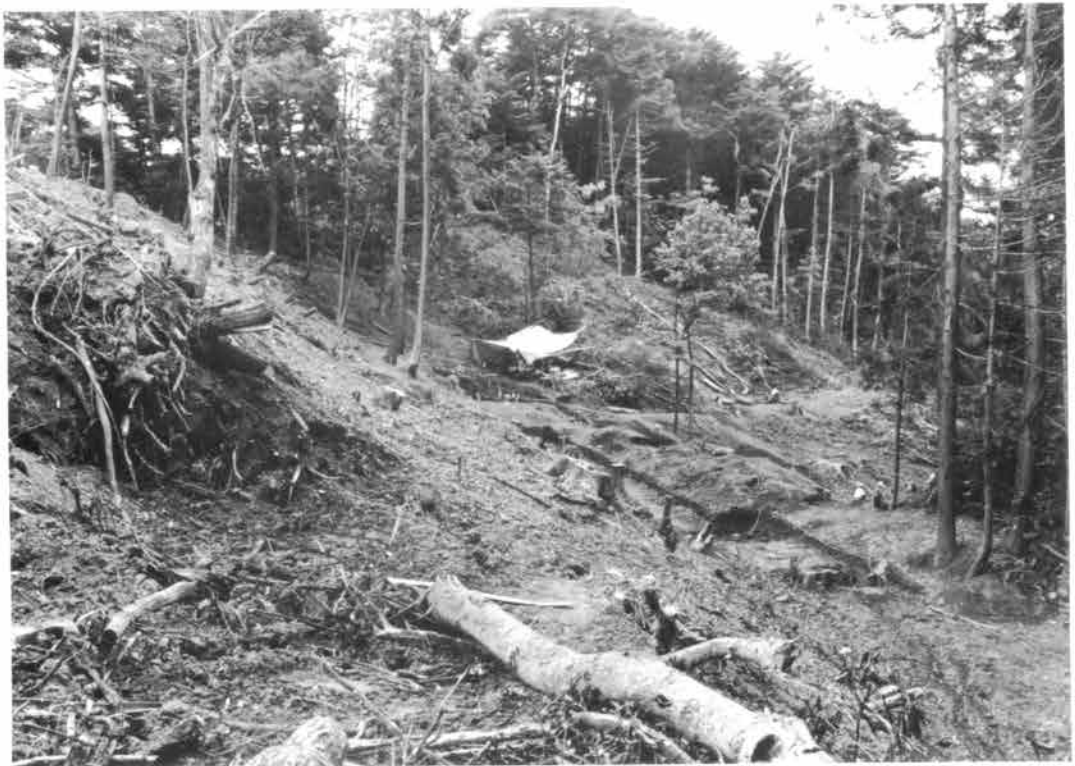
調査前の試掘（西から）
