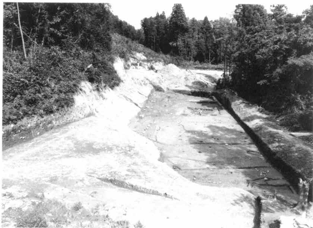
D1調査区 全景（西より）
