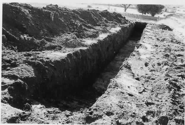
27-13 富士之井遺跡1T完掘 (東より)
