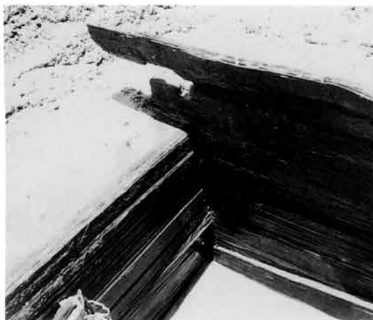
SE702 井戸側北西隅
