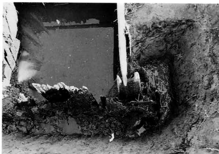
SE704 北西隅柱 隅柱の周囲にも多くの縦板が打ち込まれる
