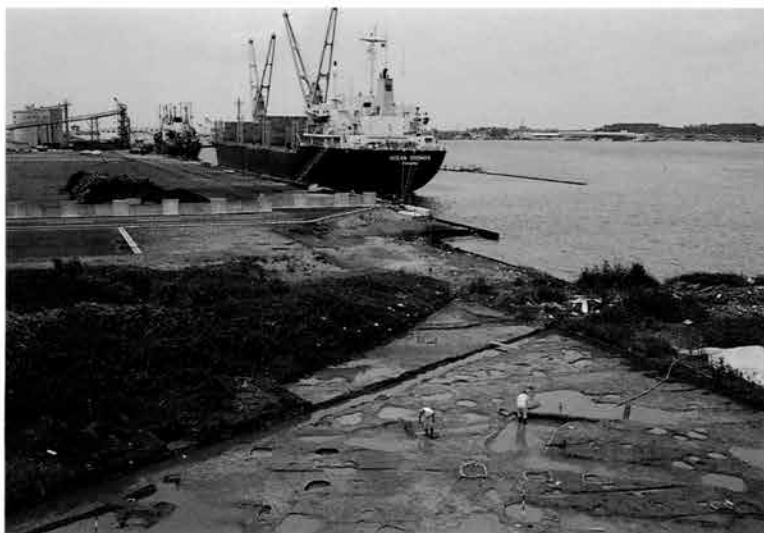
金沢港と調査区 排水溝に海水が逆流
