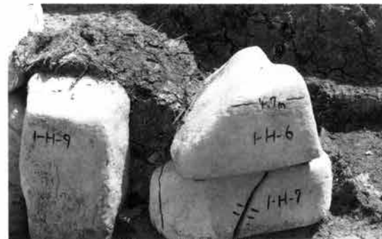
第2段側壁材除去 Fig 19 1号墳玄門構造
