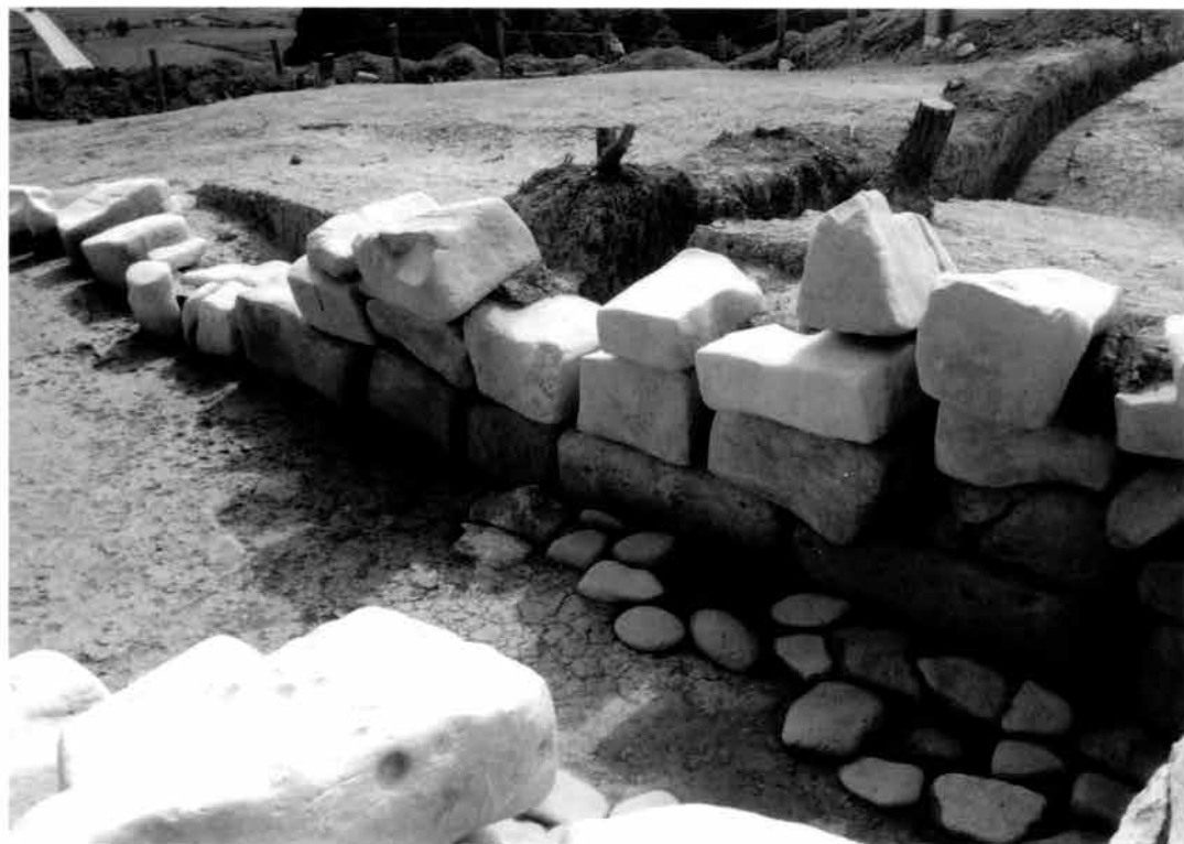
右側壁(奥より)
