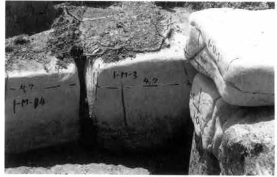
Fig 17 1号墳第二段石材設置状況
