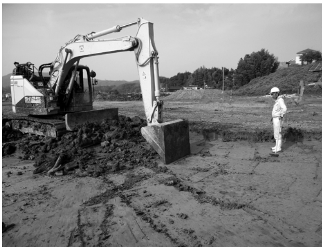
重機による表土除去
