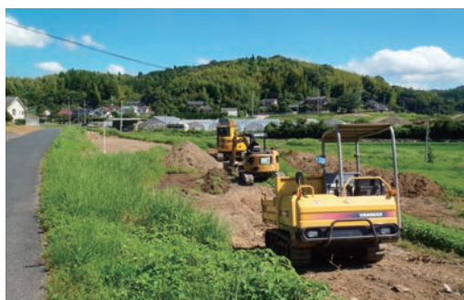
重機による表土除去
