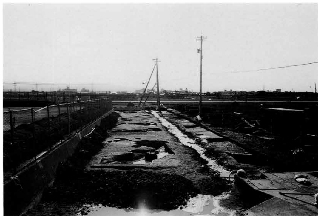
西調査区完掘状況（北から）
