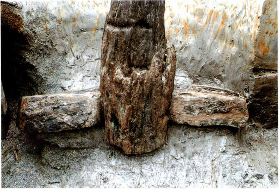
根がらみ木柱根（第6次調査）
