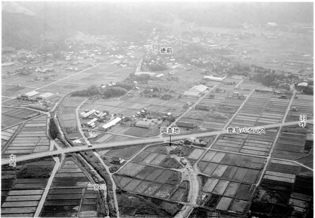
同 上（北西から）
