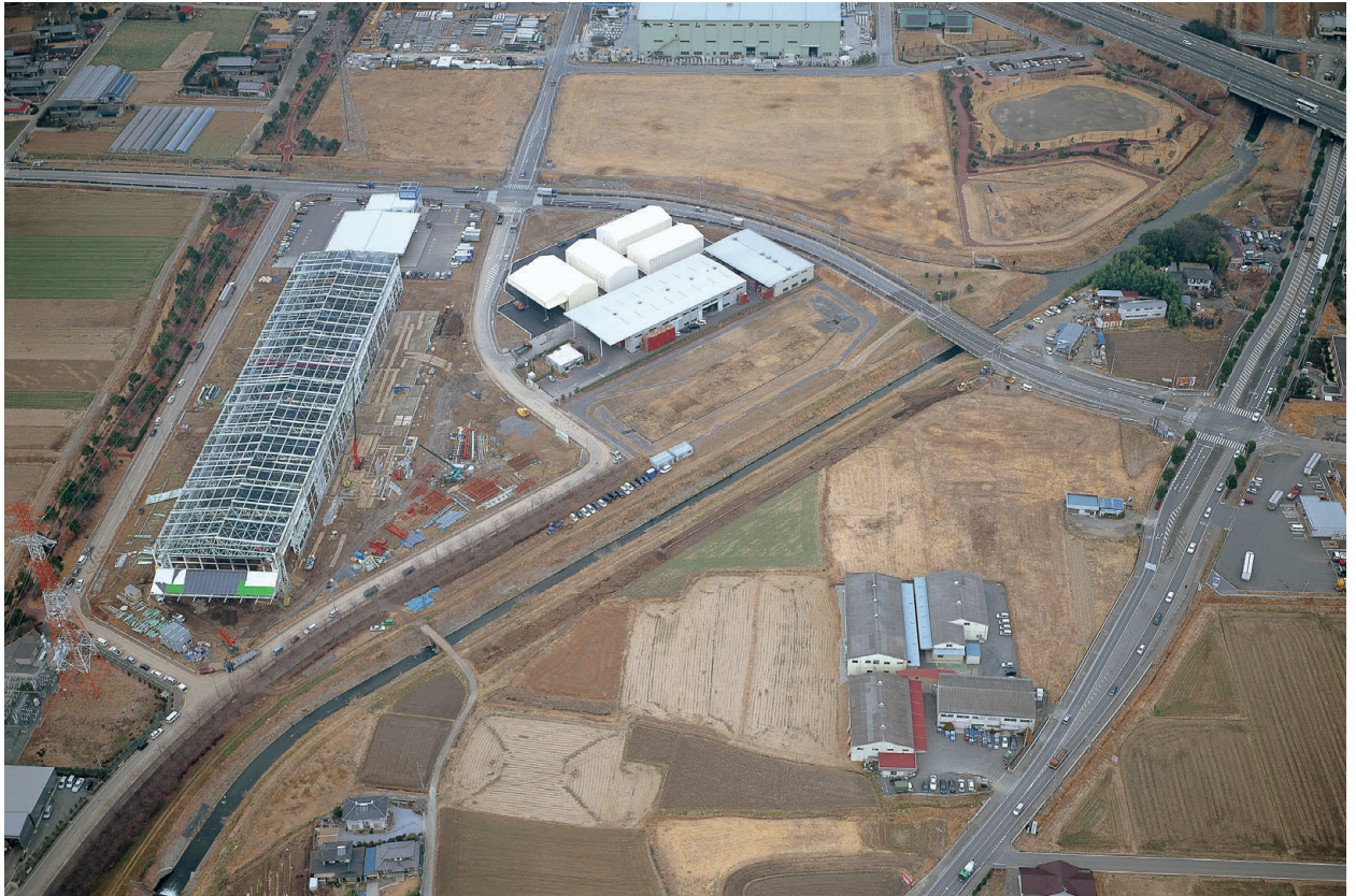
1 川越田遺跡（第3次調査）空中写真（1）（南から）
