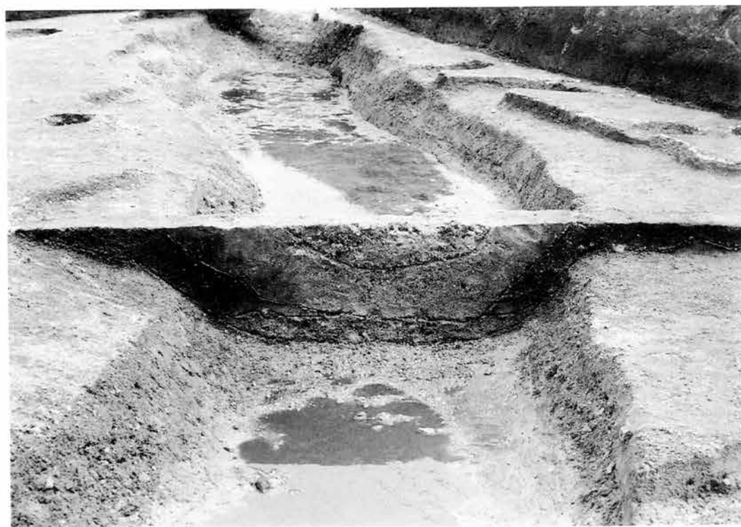
写真21 3号溝土層断面検出状況（S. P. 5～6）
