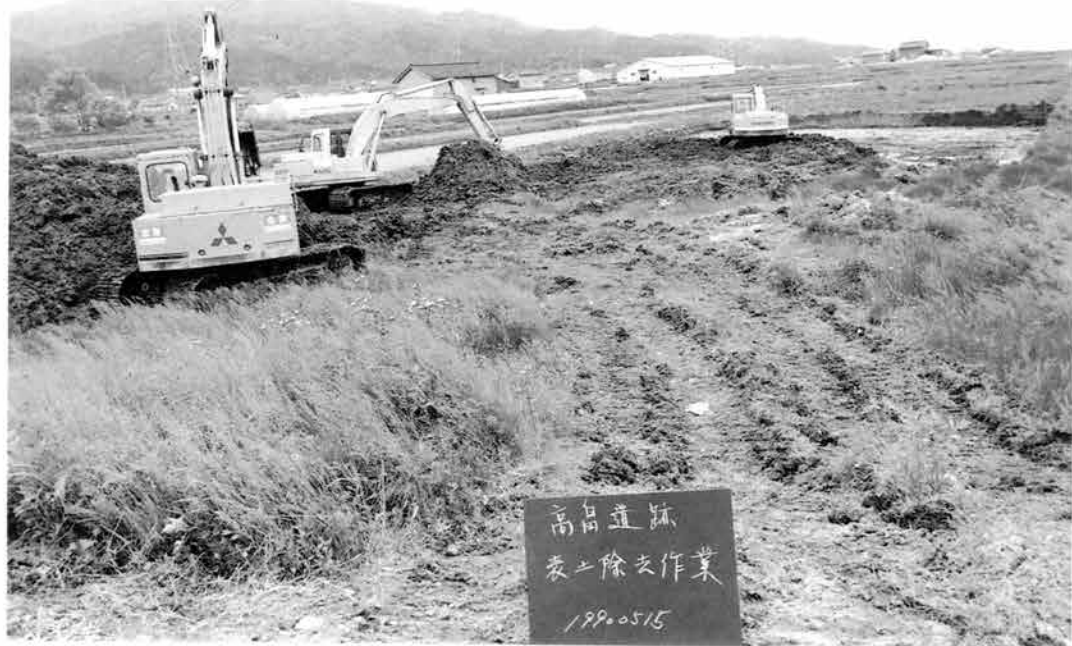
写真15 表土除去作業（北より）
