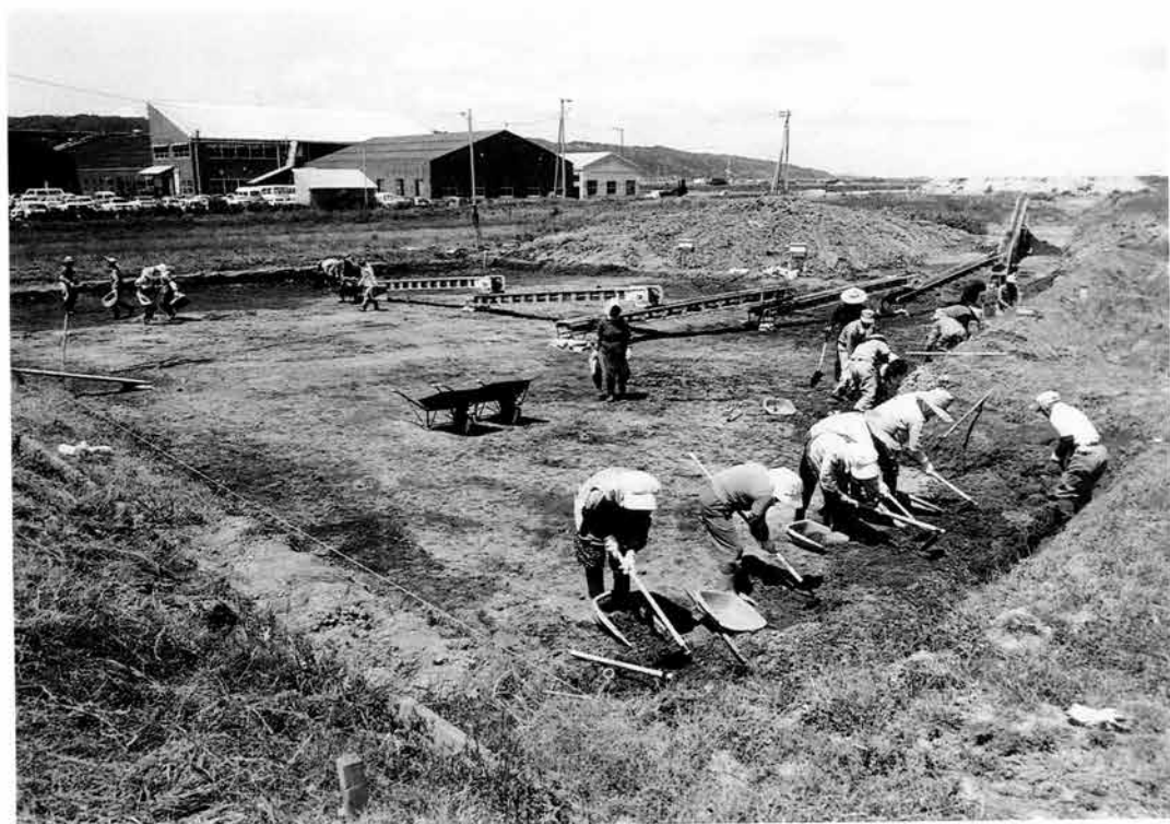
写真13 東側調査区周辺整備作業（南より）
