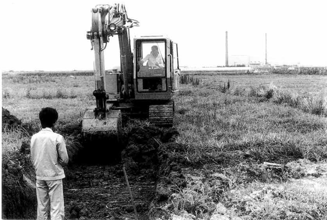
第1調査区表土除去作業
