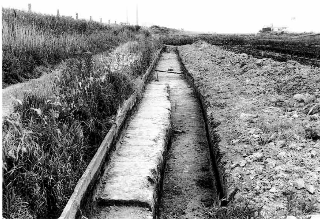
Nトレンチ 9～13区完掘状況（西から）
