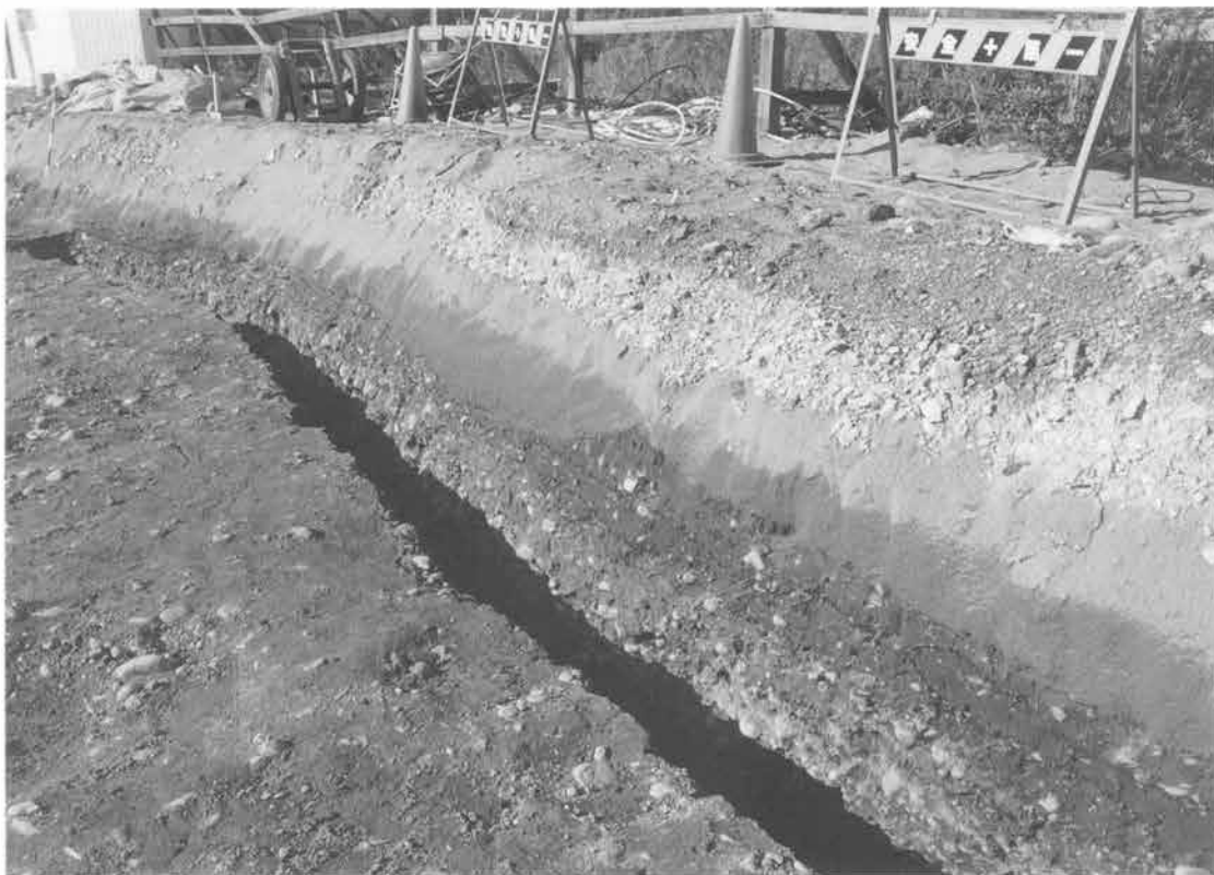
Wトレンチ 壁面
