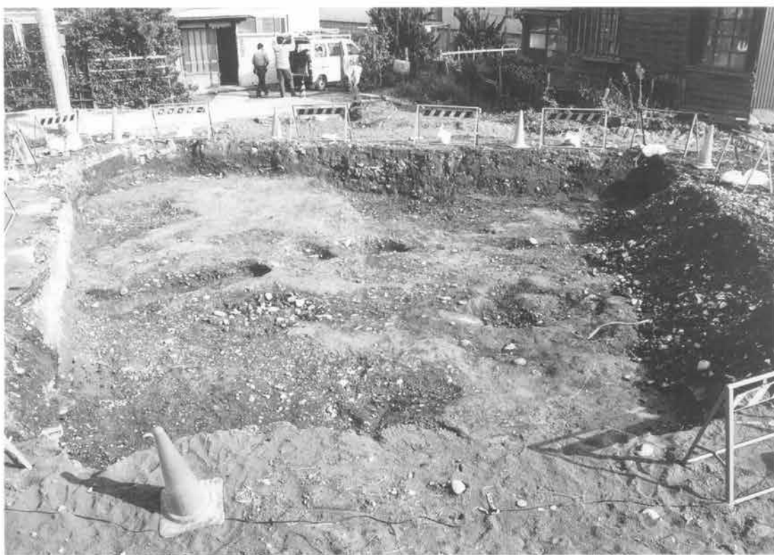
Eトレンチ 全景
