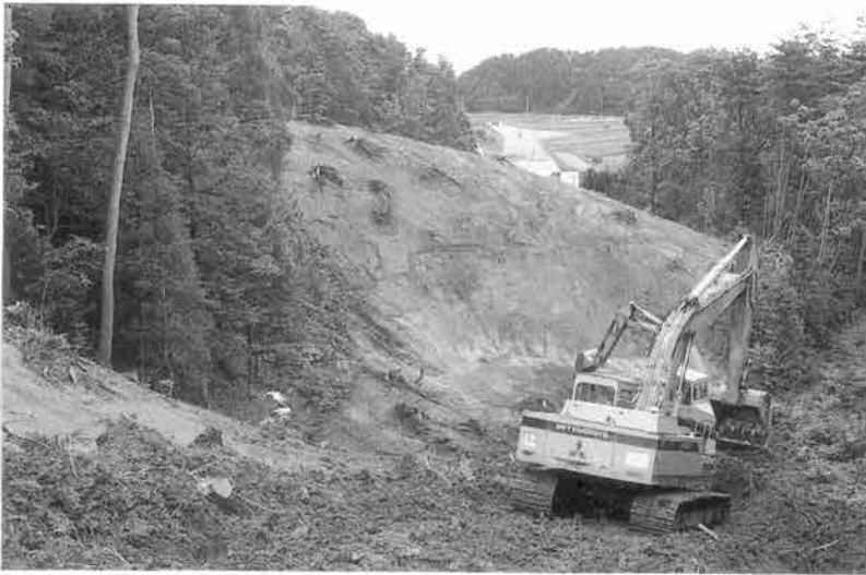
写真2 表土除去作業風景
